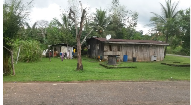
Figure 10: Maison en bois à Andem
