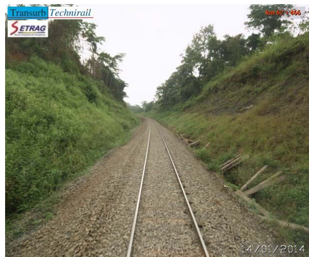
Figure 19: TBHS déposées en bordure de voie
