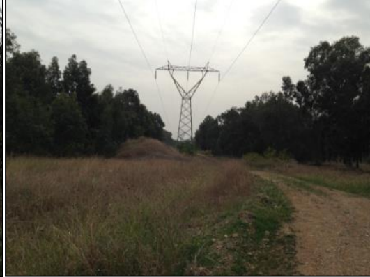
Fotoğraf 6. Elektrik iletim hattı
