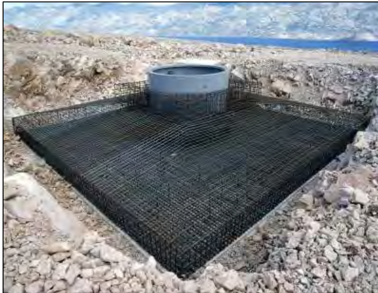
Slika br. 19: Karakteristični temelj vjetroatagata. (fotografija i karakteristični presjeci)
