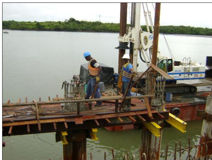
Foto 2. Piloteadora o Barrenadora para la Construcción de los Pilotes
