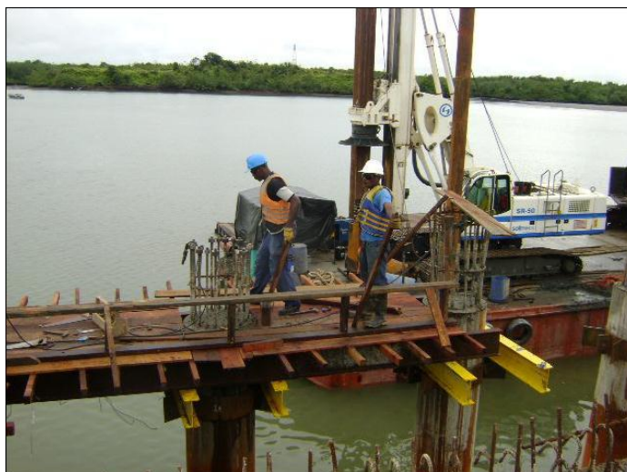
Foto 4. Piloteadora o Barrenadora para la Construcción de los Pilotes
