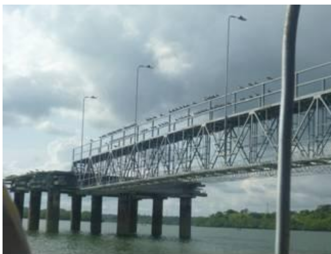
Foto 1. Piña de atraque y Pasarela de Acceso Costado Occidental
