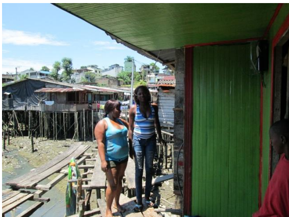
Figura No 25. Vivienda en zona de puentes
