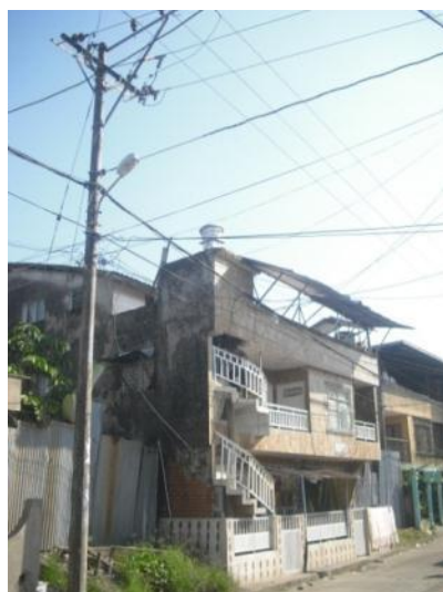
Estación 3. Ubicación de equipos
