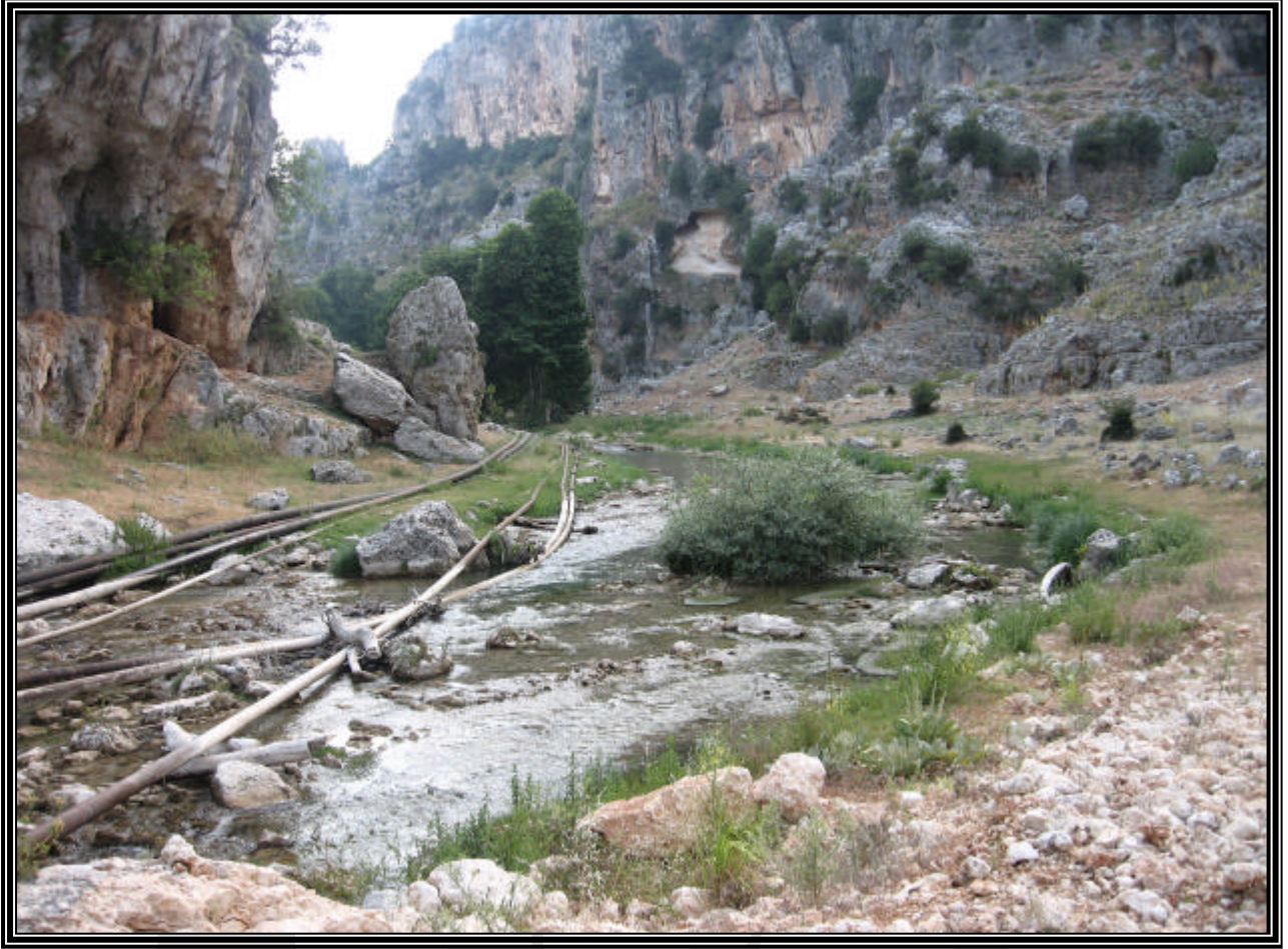
Foto.11- Regülatör Alanında Lamas Çayı Görünümü ve Su Alma Boruları
