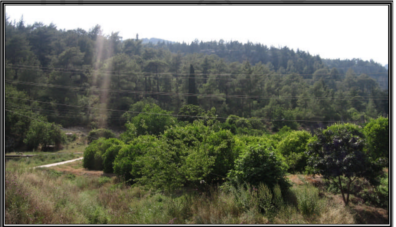
Foto.8- Lamas IV Hidroelektrik Santral Binası Alanı
