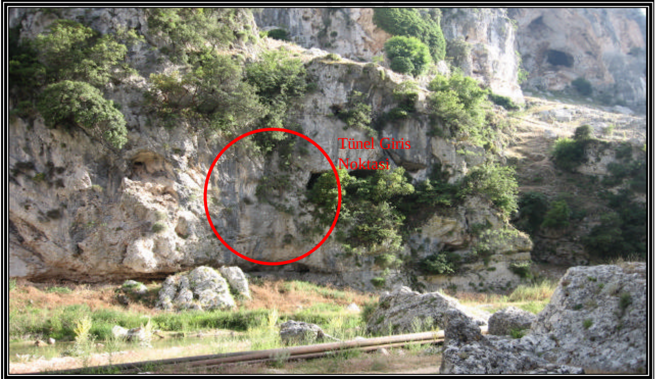
Foto.12- Lamas III-IV HES Tünel Girişi
