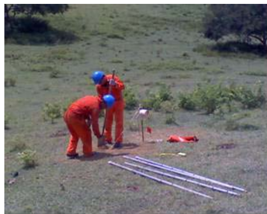
Fotografía 5-9. Cargado y tapado de pozo
