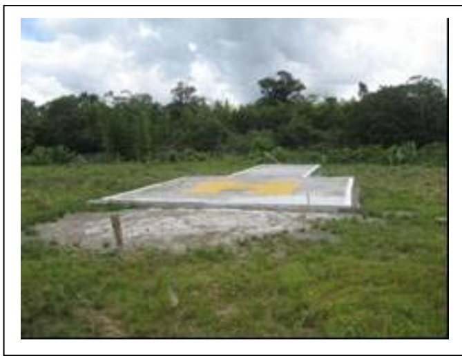
Fotografía 5-5. Helipuerto en superficie tipo para levantamientos sísmicos
