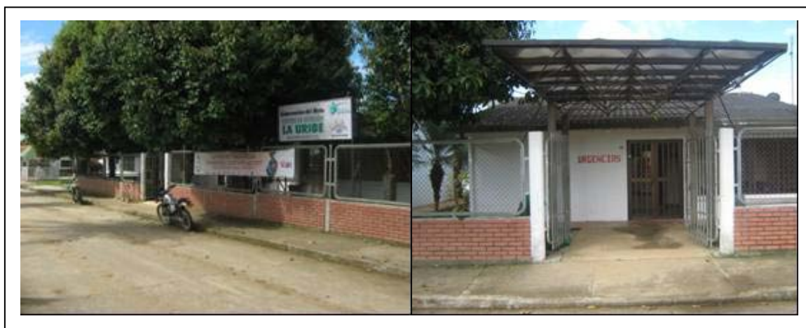
Fotografía 2-42. Centro de Atención médica y sala de urgencias, municipio de Uribe
