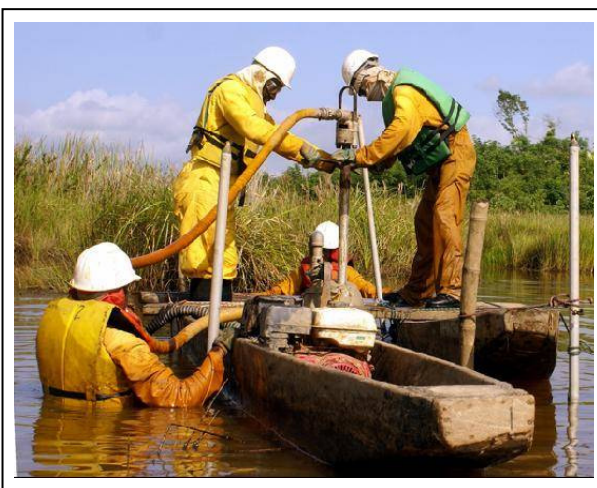
Fotografía 5-5. Perforación tipo en cuerpos de agua
