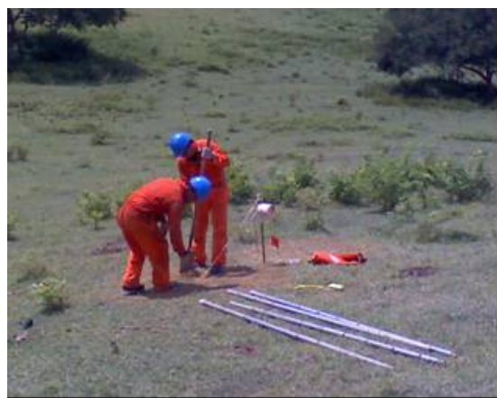
Fotografía 5-6. Cargado y tapado de pozo
