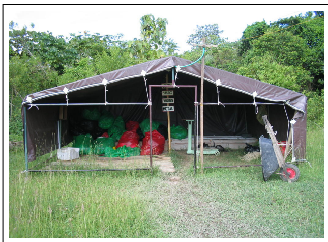
Fotografía 5-9. Caseta tipo para el almacenamiento temporal de residuos en sísmica
