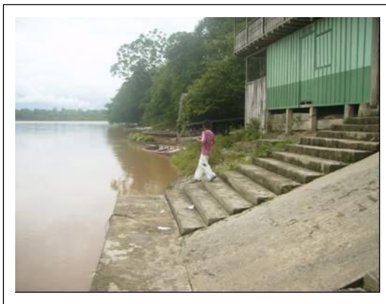
Fotografía 2-64. Puerto fluvial en el casco urbano de Puerto Guzmán
