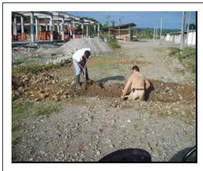
Fotografía 2-55. Apertura de redes de alcantarillado en Puerto Guzmán
