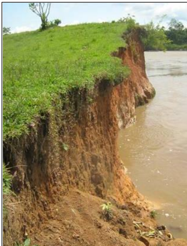
Fotografía 2-14. Socavación de cauce del río Caquetá en el sector norte del área de estudio en los alrededores de la Escuela El Vergel
