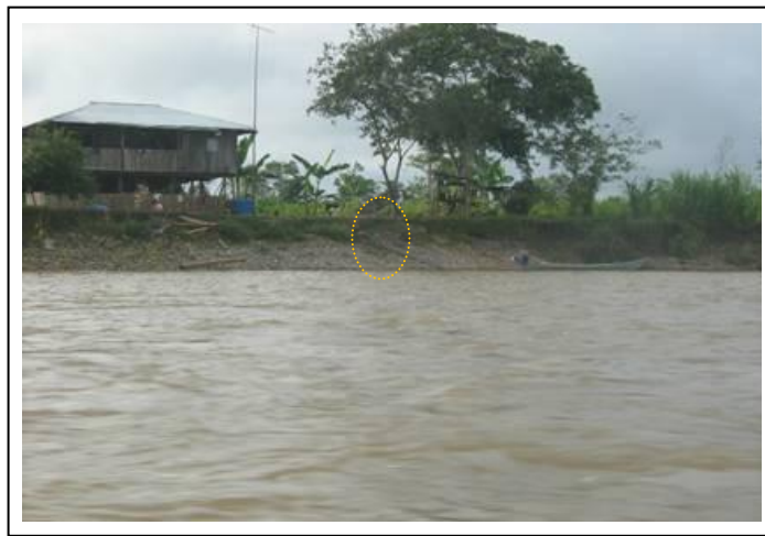
Fotografía 2-21. Captación de agua para consumo humano sobre el río Caquetá
