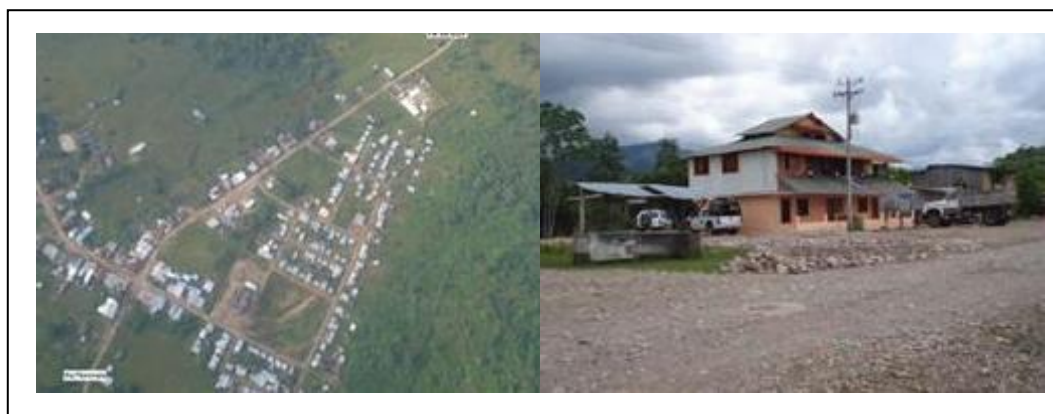
Fotografía 2-70. Malla vial del municipio de Piamonte y Despacho de vehículos de transporte público
