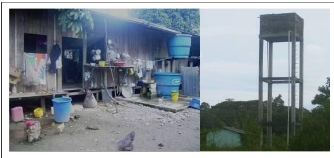
Fotografía 2-72. Sistemas de recolección de agua lluvia en Puerto Rosario y Tanquen elevado de la vereda Porvenir
