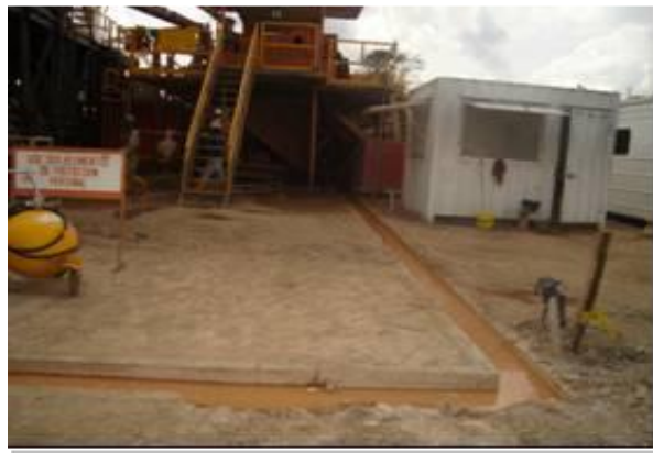
Fotografía 7-2. Cuneta perimetral tipo en la zona del taladro
