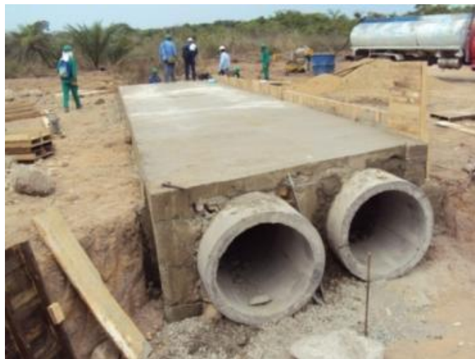
Fotografía 7-5. Construcción de alcantarillas
