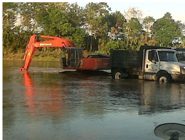
Fotografía 5-5. Extracción ilegal de material del río Caquetá en el área del proyecto
