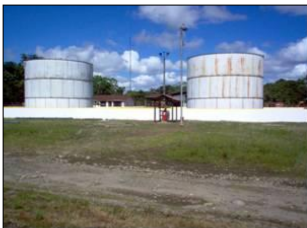
Fotografía 5-8. Vista de la batería Linda
