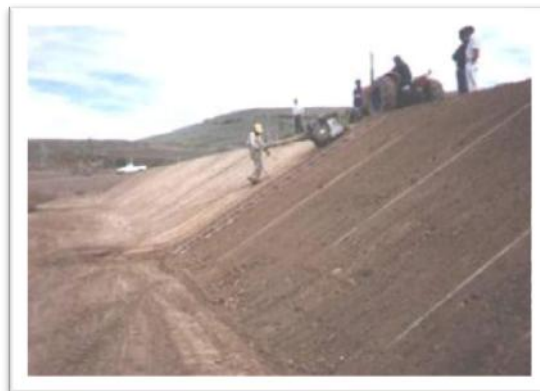
Fotografía 4-8. Conformación del talud de ZODMEs
