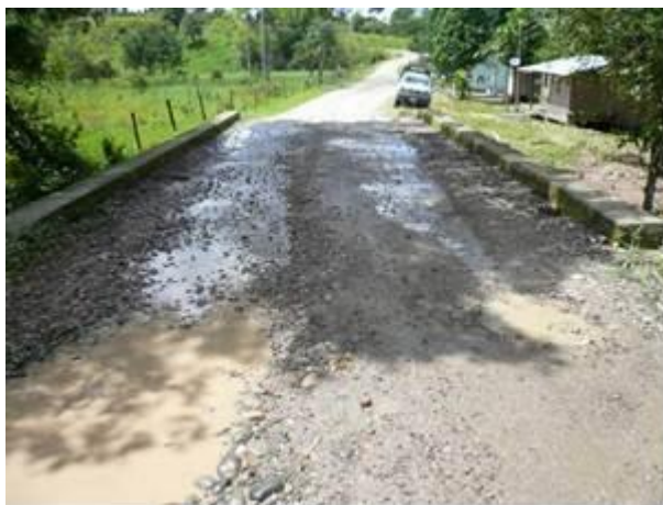
Fotografía 2-4. Puente sobre la quebrada Dedoyaco K7+700
