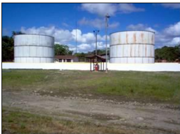
Fotografía 2-34. Vista de la batería Linda
