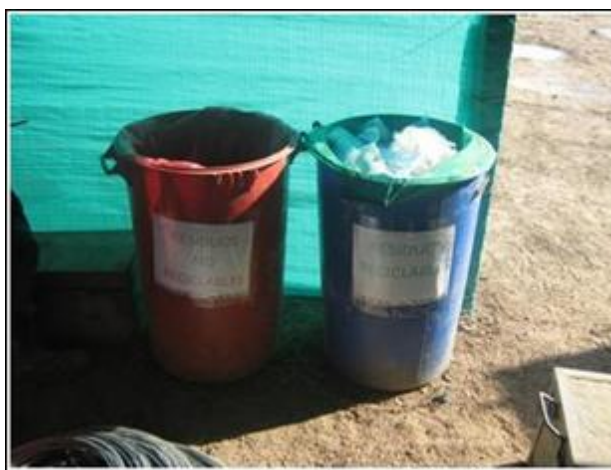
Fotografía 2-41. Almacenamiento temporal de residuos en las obras civiles
