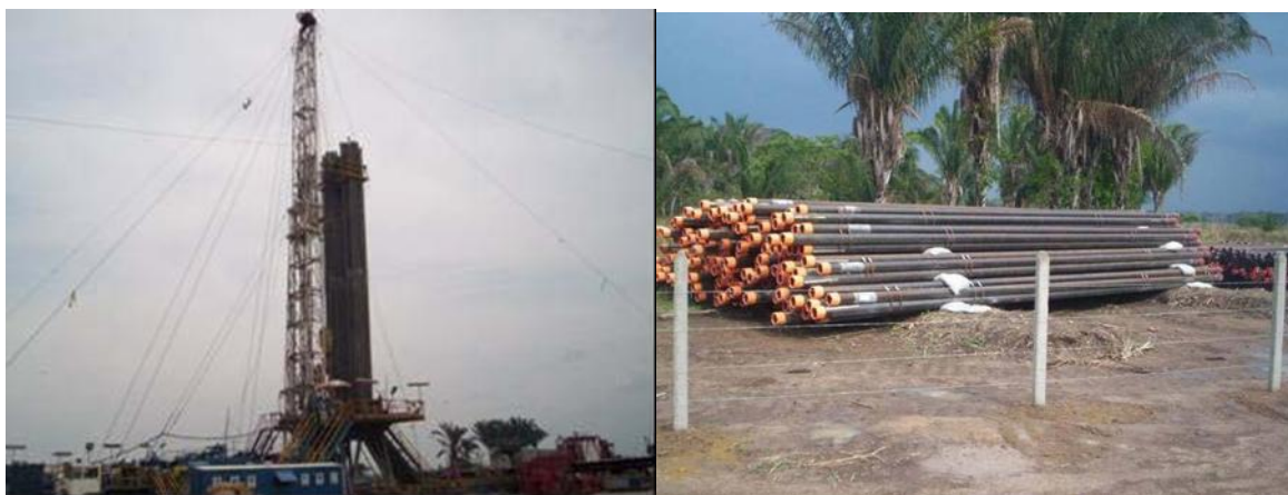
Fotografía 2-43. Tubería de perforación
