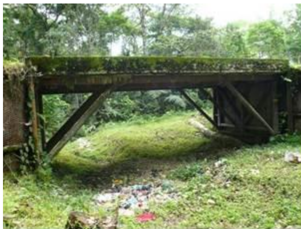
Fotografía 2-16. Puente sobre el brazo del río Inchiyaco K122+800
