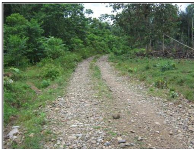
Fotografía 2-37. Vía Cabildo Rumiñawi – La Punta
