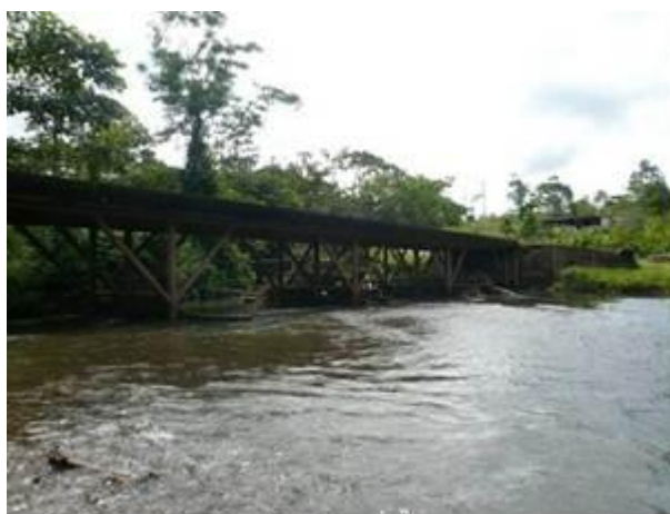
Fotografía 2-7. Puente sobre la quebrada Nabueno K10+000
