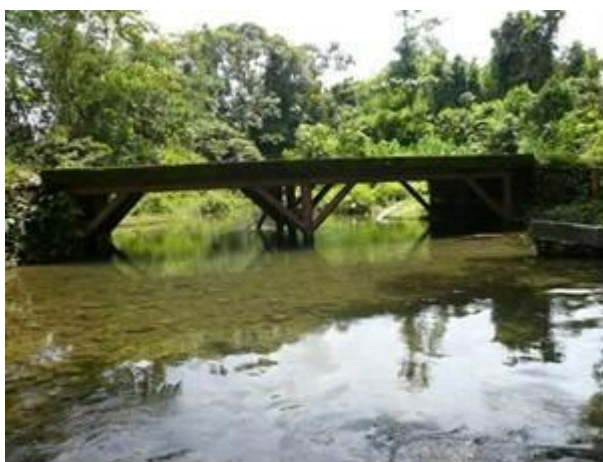
Fotografía 2-5. Puente sobre la Quebrada San Pablo K9+300
