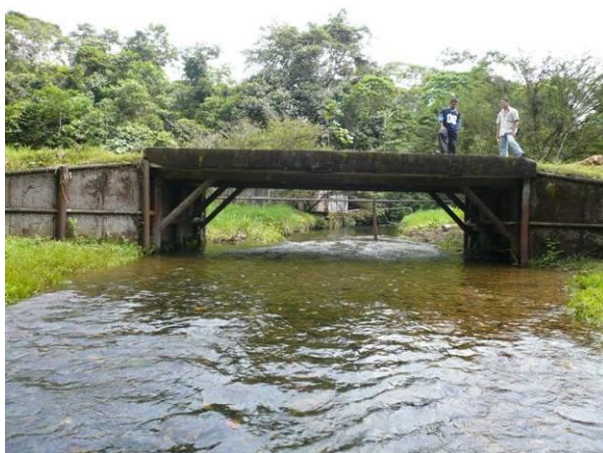
Fotografía 2-9. Puente sobre la quebrada Tufán K11+100
