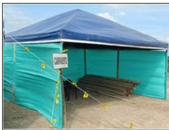
Fotografía 2-40. Caseta temporal para el almacenamiento de los materiales
