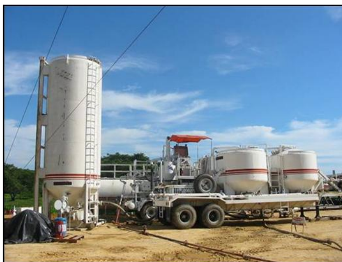
Fotografía 2-48. Equipo de cementación utilizado en perforación
