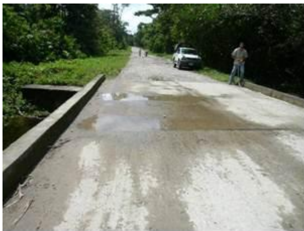
Fotografía 2-2. Puente sobre la quebrada Guascayaco K6+300
