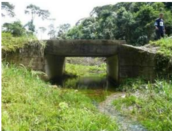
Fotografía 2-8. Puente sobre la quebrada La Balsita K10+900
