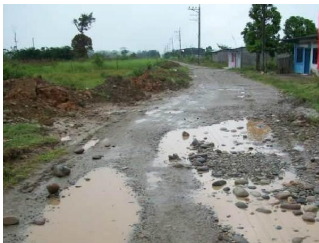
Fotografía 2-25. Formación de baches en el K8+630 (vereda el Bombón)
