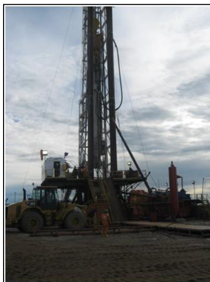
Fotografía 2-42. Torre de perforación
