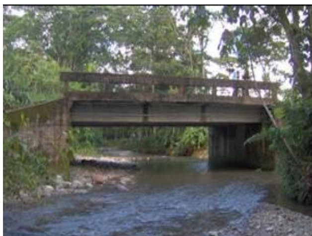
Fotografía 2-13. Puente sobre la quebrada Witota K123+400
