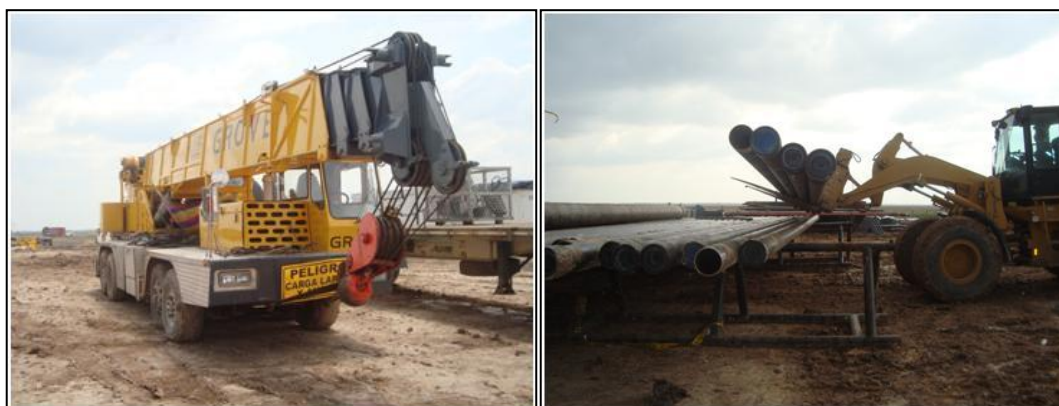
Fotografía 2-47. Maquinaria utilizada durante la perforación
