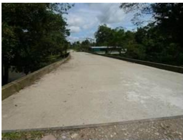
Fotografía 2-3. Puente sobre la quebrada Guayuyaco K7+500
