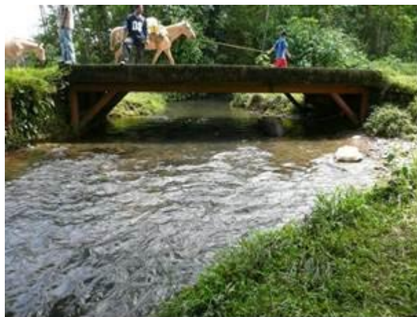
Fotografía 2-6. Puente sobre brazo de La Quebrada Nabueno K9+900
