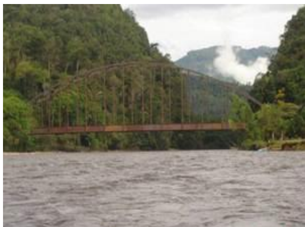
Fotografía 2-11. Puente sobre el río Fragua en vía Florencia - Piamonte
