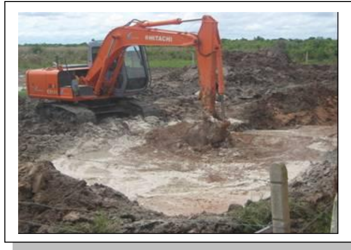
Fotografía 10-7. Mezcla de cortes con cal y tierra para su estabilización
