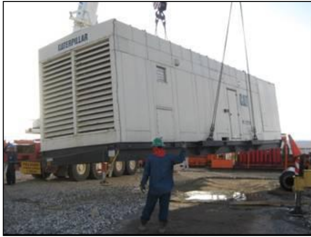
Fotografía 10-1. Cargue de equipos durante la desmovilización
