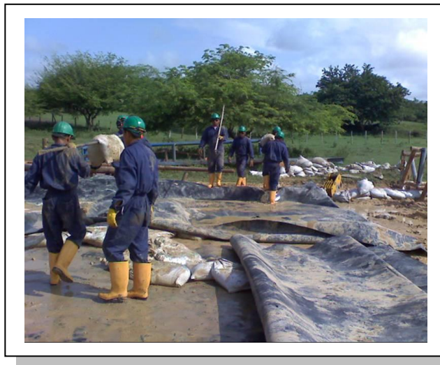
Fotografía 10-8. Limpieza del área
