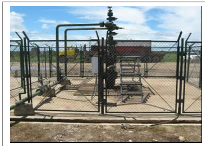
Fotografía 10-3. Enmallado tipo del contrapozo
