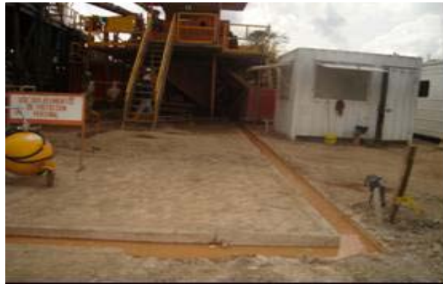
Fotografía 7-2. Cuneta perimetral tipo en la zona del taladro
