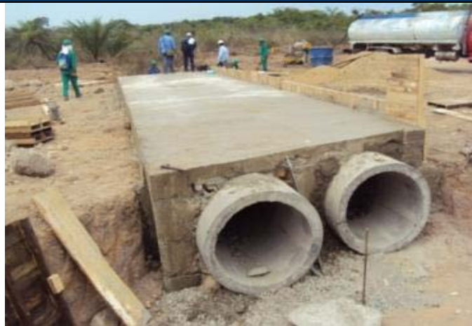
Fotografía 7-5. Construcción de alcantarillas
