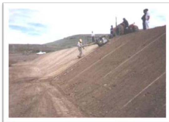
Fotografía 4-9. Conformación del talud de ZODMEs
