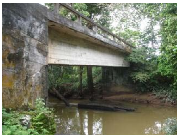
Fotografía 4-2. Sitio sugerido como punto de captación a un costado del puente en concreto ubicado sobre el río Mandúr (vereda El Porvenir)
