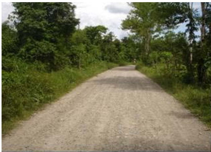
Fotografía 2-2. Vía de acceso Puerto Guzmán – Vereda San Luis.
