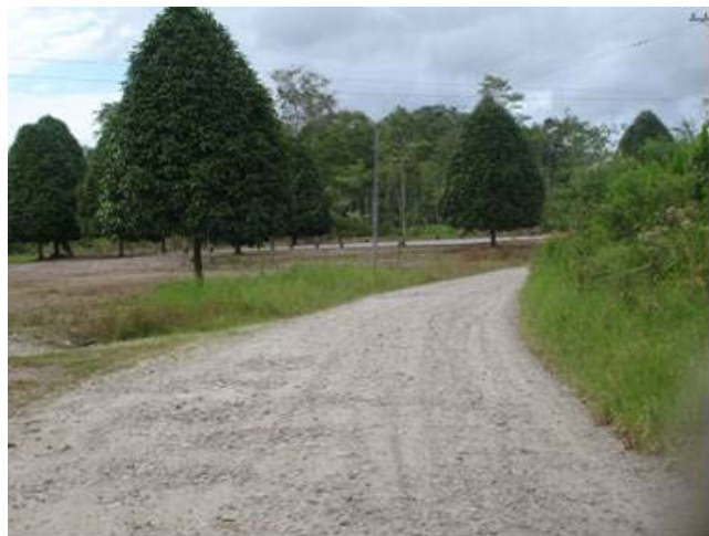
Fotografía 2-6. Tramo El Bombón – San Luis a la altura de la escuela de la vereda San Luis
