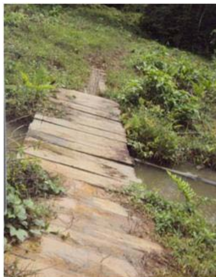
Fotografía 2-12. Puente en madera existente sobre el caño Azul en la vereda Las Villas (K1+880)
