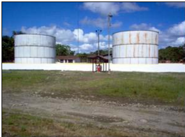
Fotografía 2-19. Vista de la batería Linda
