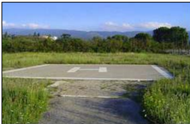
Fotografía 2-25. Helipuerto Tipo para transporte de personal
