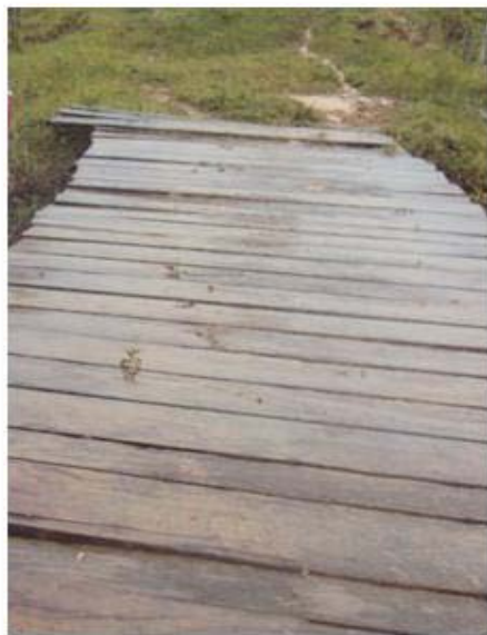
Fotografía 2-14. Puente en madera sobre la quebrada Agua Clara (K3+050)
