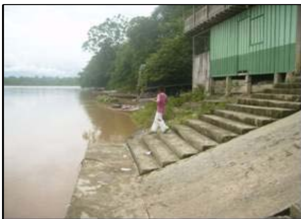
Fotografía 2-16. Puerto del municipio de Puerto Guzmán
