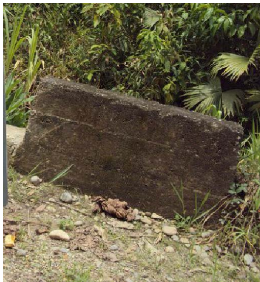
Fotografía 2-7. Alcantarilla tipo presente en la vía El Bombón – San Luis
