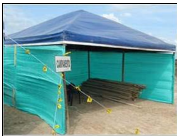
Fotografía 2-26. Caseta temporal para el almacenamiento de los materiales
