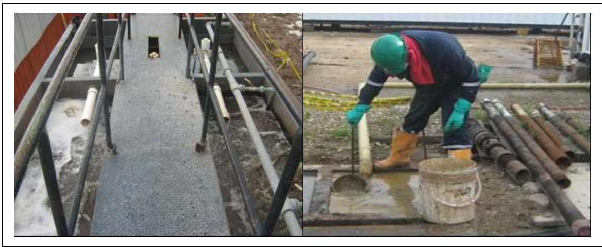
Fotografía 10-4. Estructuras Sanitarias a desmantelar
