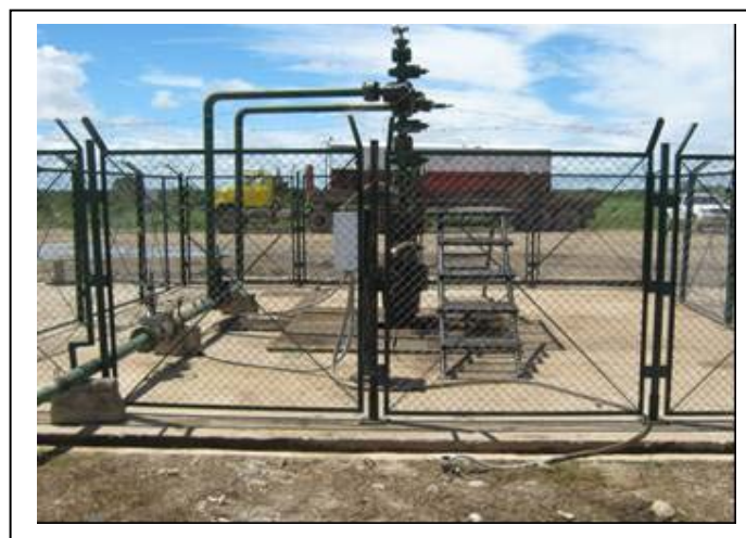
Fotografía 10-3. Enmallado tipo del contrapozo
