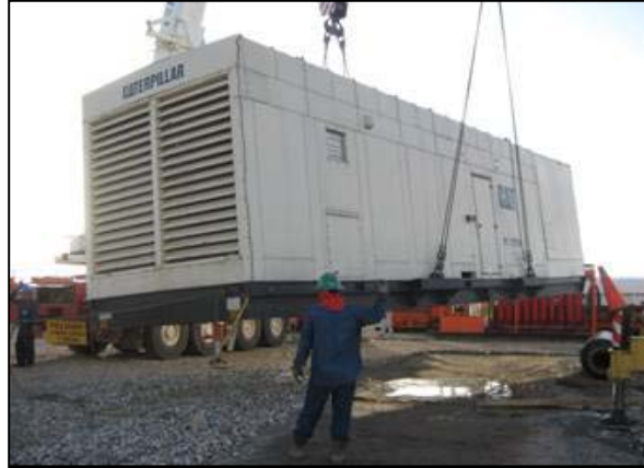
Fotografía 10-1. Cargue de equipos durante la desmovilización
