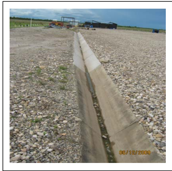
Fotografía 10-5 Cunetas Perimetrales a demoler en caso de abandono
