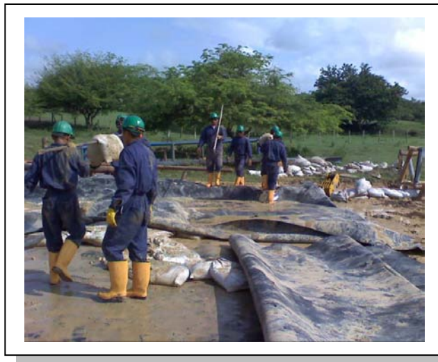
Fotografía 10-8. Limpieza del área
