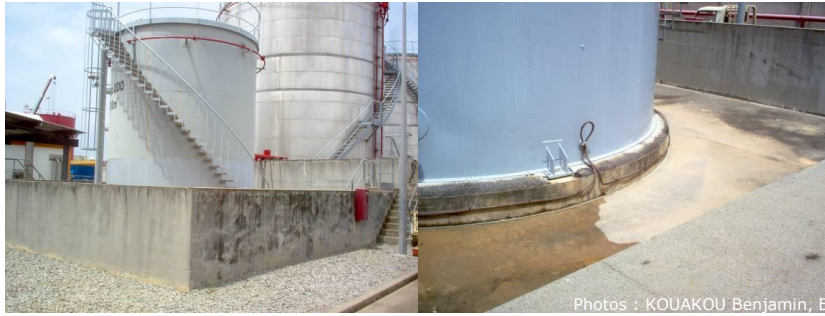
Figure 40: Exemples de muret et aire de rétention étanches
