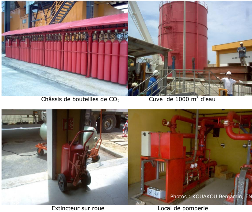
Figure 36: Moyens de prévention et de lutte contre l'incendie opérationnel à CIPREL II
