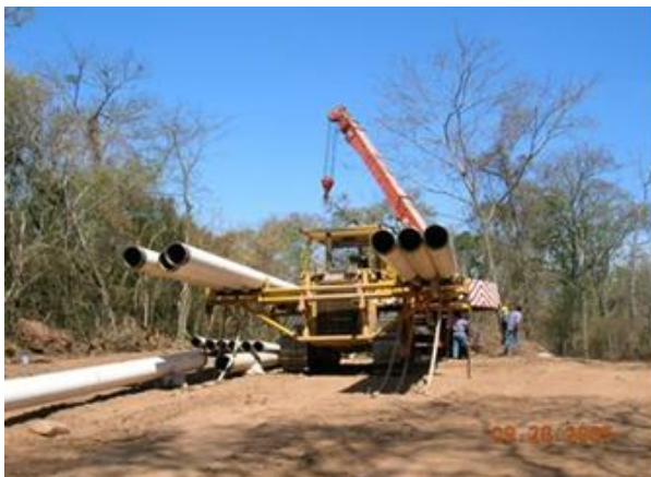
Foto 3-4. Equipo para transporte e instalación de tubería Foto 3-5. Tendido de tubería
