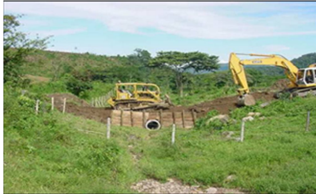
Foto 3-1. Obra típica para control geotécnico e zonas o cruces especiales
