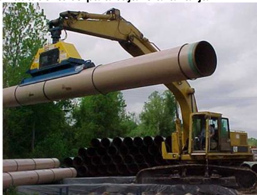
Foto 3-3. Imagen típica de la izada del tubo para bajarlo a la zanja.
