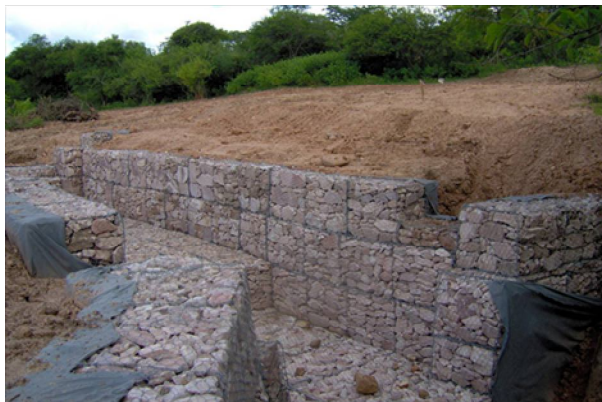
Foto 3-8. Colocación de Gaviones para estabilización de terrenos
