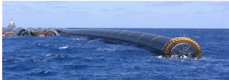
Figura 3.4.17. Transporte de la Tubería del Emisario Submarino
