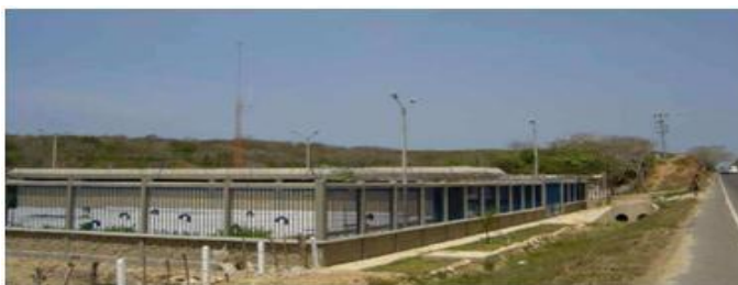
Figura 3.4.7. Acueducto Zona Norte
