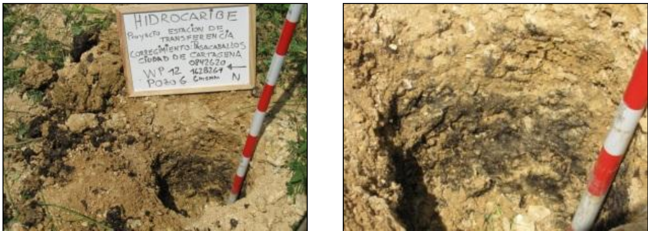
Figura 1.6.27. Pozos de sondeo con materiales de obra sobre la perimetral
