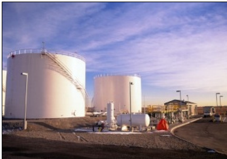
Figura 2.3.12 Modelo de tanques de techo fijo
