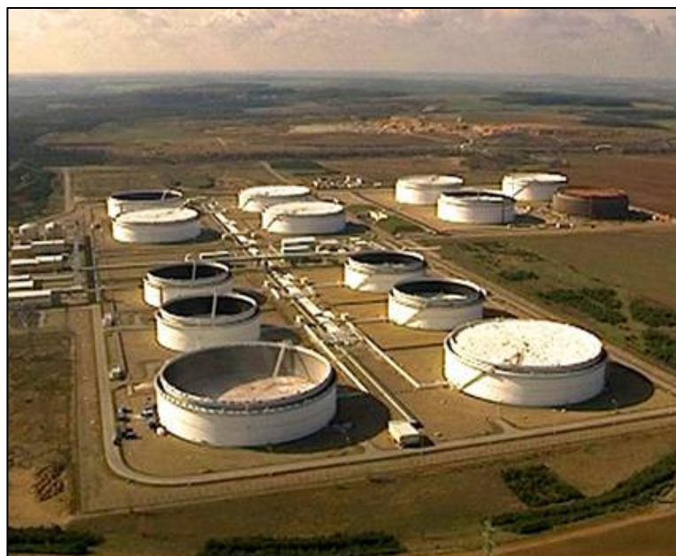
Figura 2.3.11 Modelo de tanques de techo flotante
