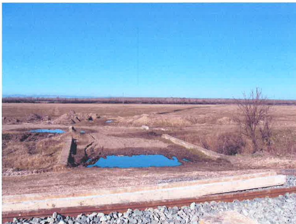
Изглед към площадката от юг, от към ЖП линията и строящата се гара
