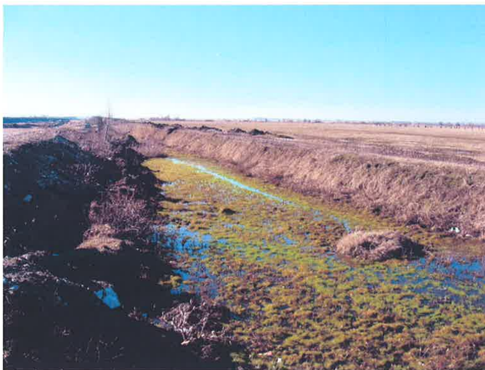
Отводнителен канал по южната граница на площадката
