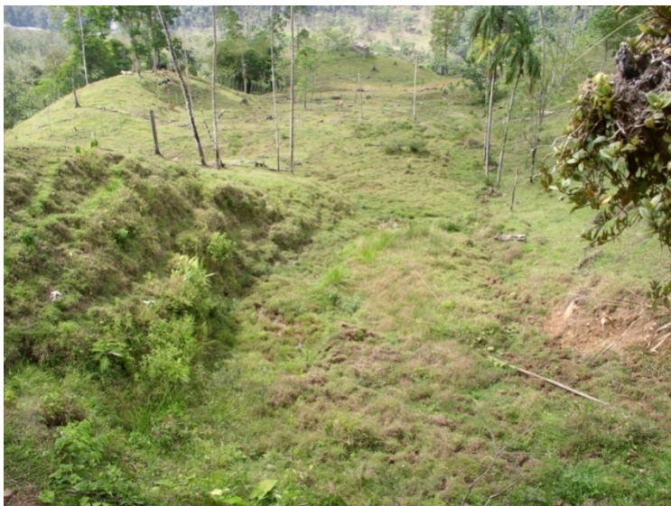
Fotografía 10.5.1 Vista hacia el Norte del sitio de la escombrera 1.
