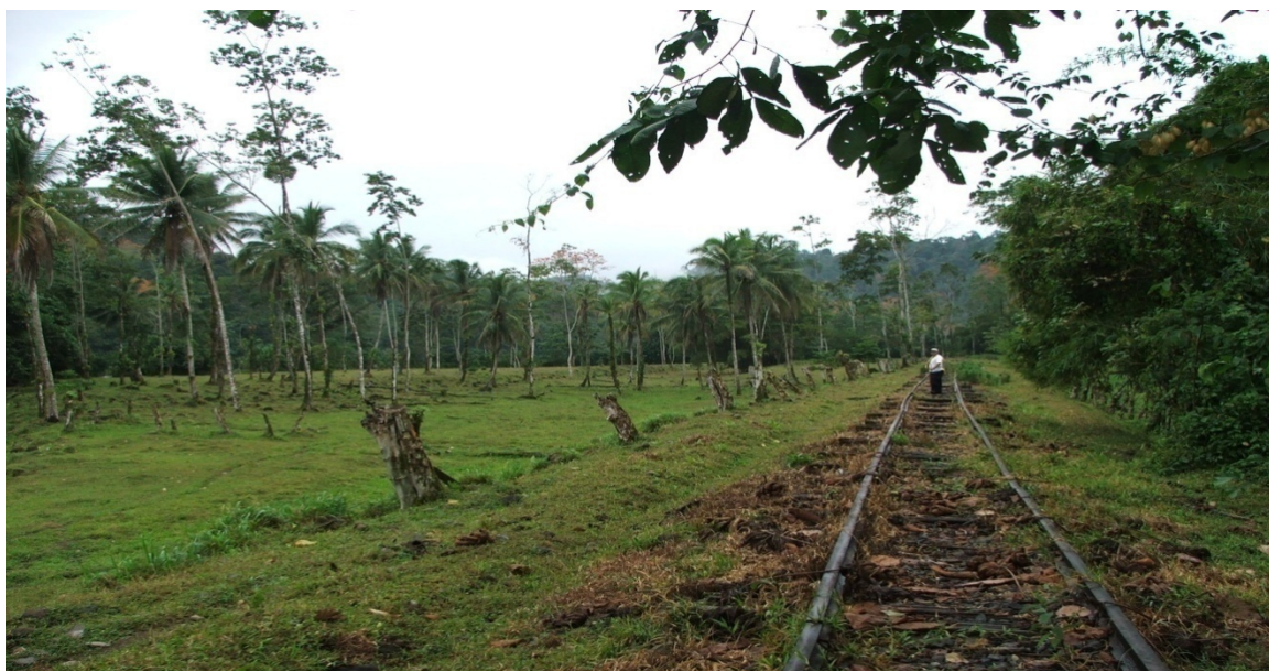
Fotografía 9.10.11.1 Detalle fotográfico de la Vía Férrea en el tramo T1
