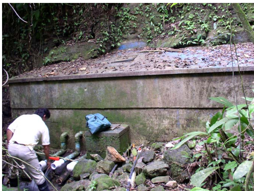
Fotografía 7.5.2.9. Toma de agua de la comunidad de Bajo 52 Millas
