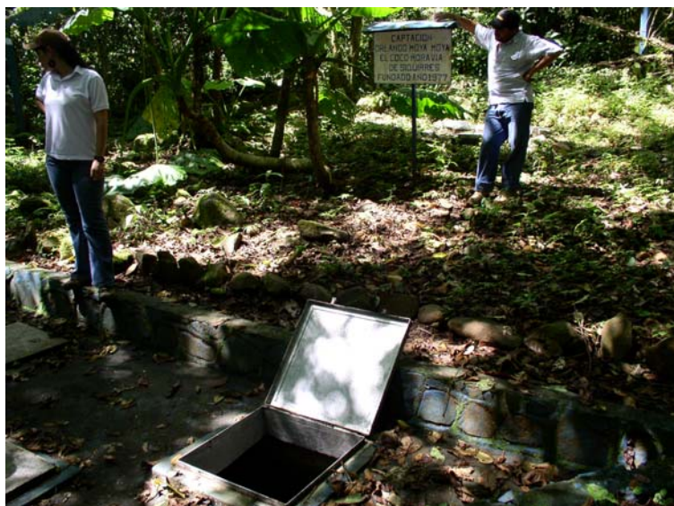
Fotografía 7.5.2.5. Captación del acueducto Moravia y El Coco de Siquirres
