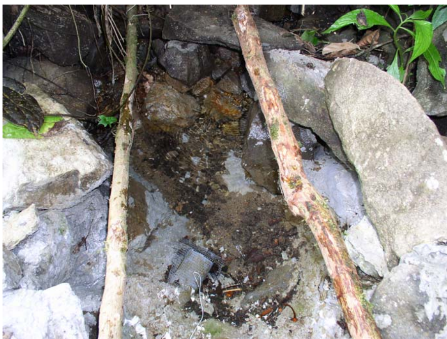
Fotografía 7.5.2.2. Captación del acueducto de la comunidad de San Antonio.
