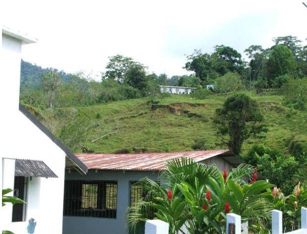
Fotografía 7.2.11: La comunidad de San Antonio se asienta sobre formaciones sedimentarias. La composición y estructura del tipo de roca sedimentaria localizada en estos sectores favorece la acción de procesos de remoción en masa. La forma de las Colinas observadas en la foto evidencia el efecto del desplazamiento del suelo, originando procesos de solifluxión en capas, terracetos y pie de vaca.
