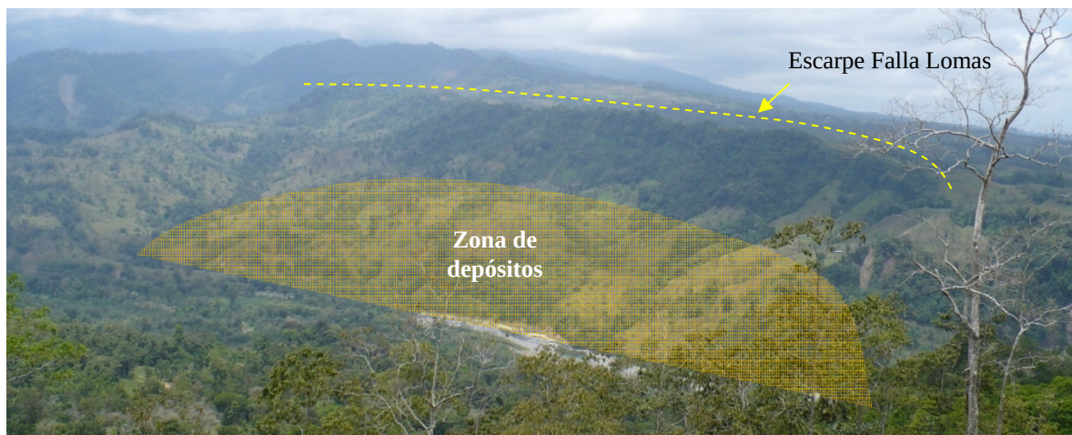
Fotografía 7.1.13. Vista hacia aguas arriba de la falla Lomas
