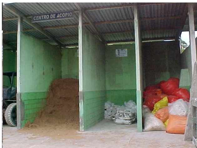
Fotografía 5.88 Centro de acopio para materiales de bajo riesgo
