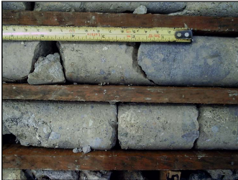
Fotografía 7.1.5. Detalle de las brechas de Doan, núcleos de perforación de sitio de presa.
