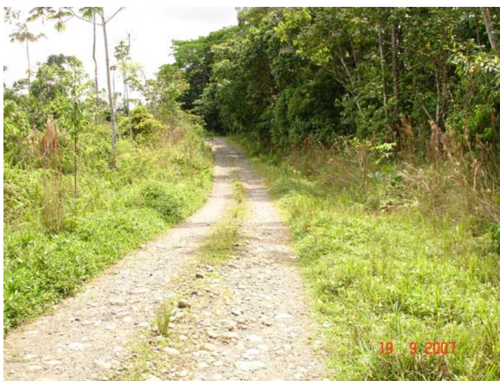
Fotografía 5.68 Vista del tramo 3 de la finca de Plywood
