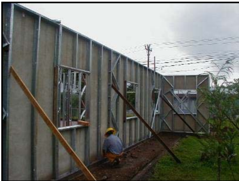
Fotografía 5.41 Forro de paredes e instalación de tuberías
