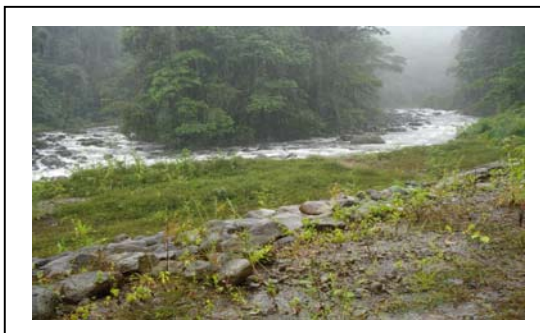
Fotografía 5.25. Dique de protección
