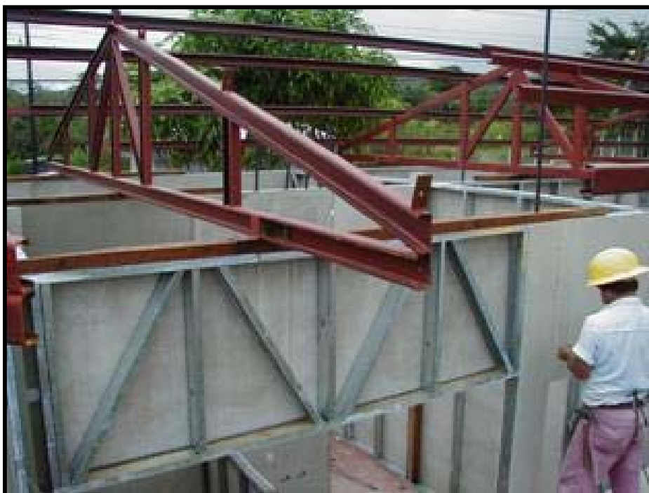
Fotografía 5.42 Proceso constructivo. Colocación de cerchas.
