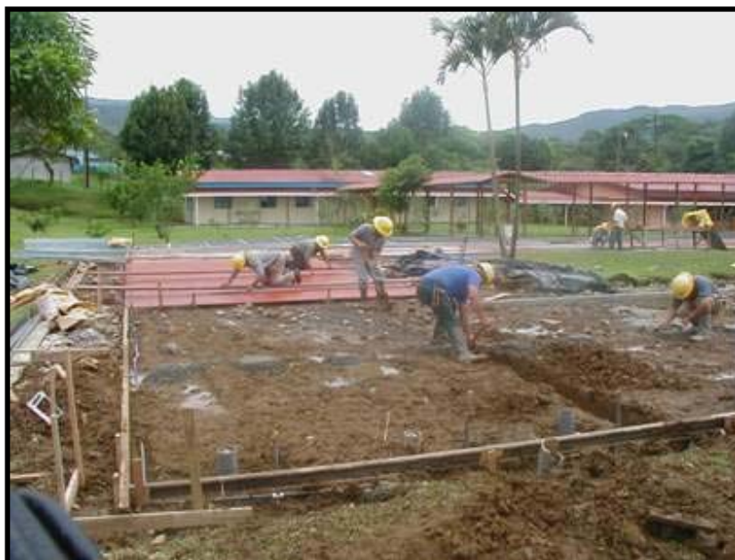
Fotografía 5.39 Proceso constructivo de la chorrea de pisos
