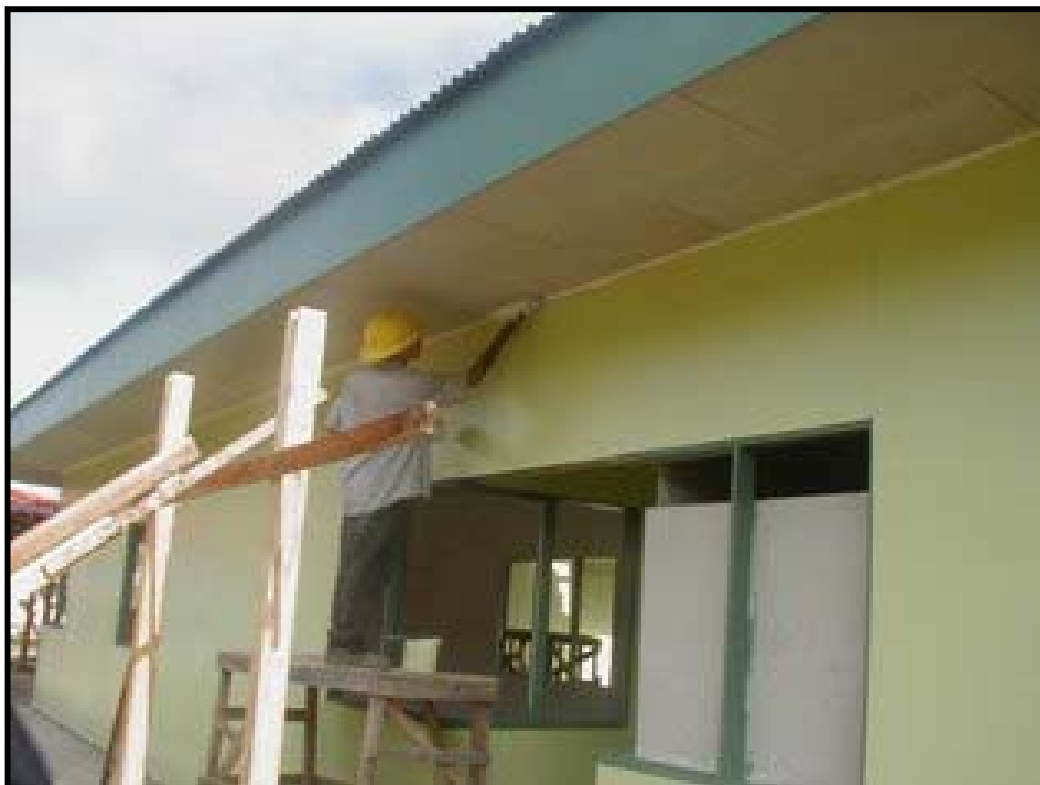
Fotografía 5.43 Colocación de cubiertas
