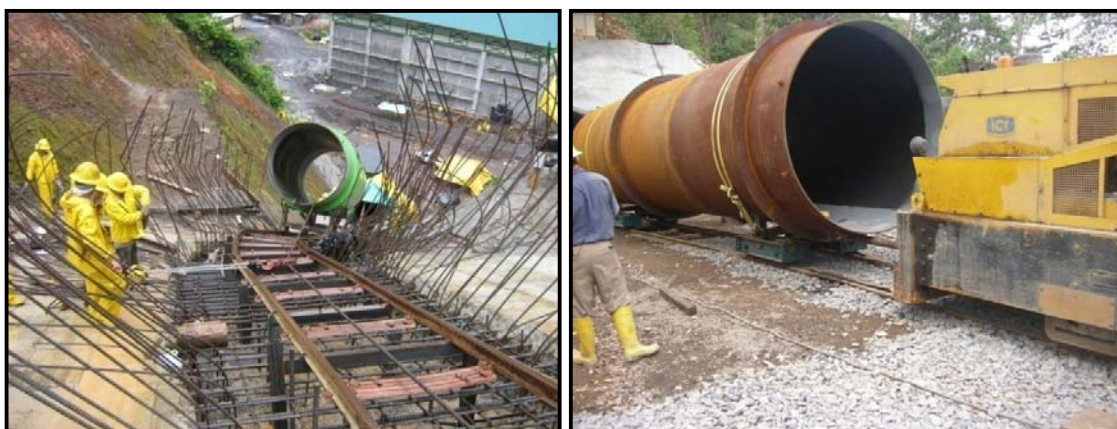
Fotografía 5.13 Montaje de tubería y blindajes
