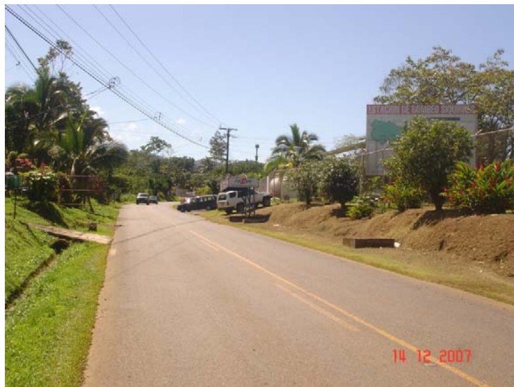
Fotografía 5.62 Carretera a Turrialba. Se observa una estación de bombeo del oleoducto de RECOPE
