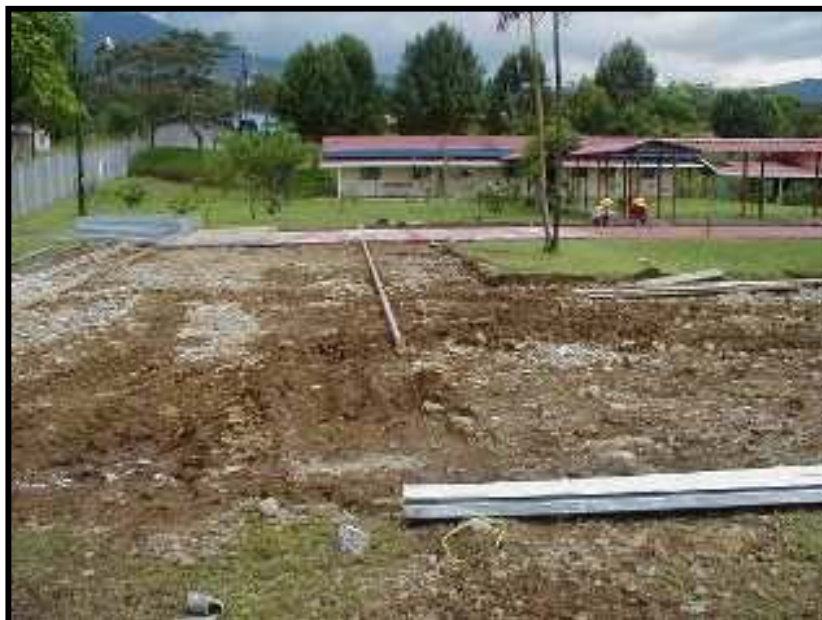
Fotografía 5.38 Limpieza para construcción de instalaciones
