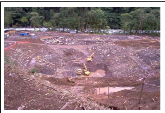
Fotografía 5.24. Excavación a cielo abierto
