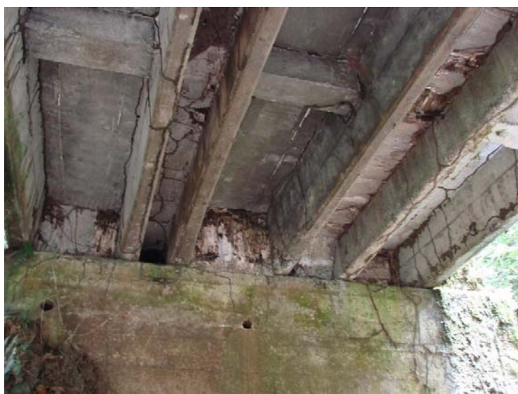
Fotografía 5.63 Vista inferior del puente sobre quebrada Guayacán
