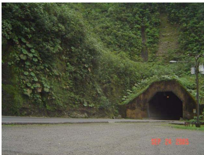
Fotografía 5.60 Vista del costado sur de la entrada del Túnel Zurquí.
