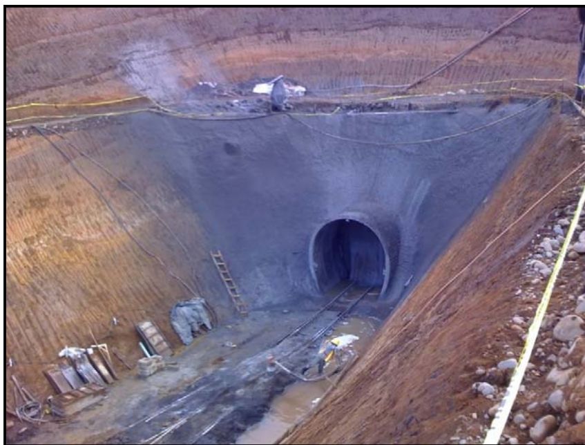
Fotografía 5.1 Vista de un portal de túnel
