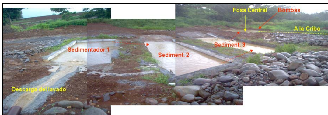
Fotografía 5.35. Disposición de batería de sedimentadores
