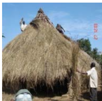
Construction d'une case à toit de chaume à Traorela
