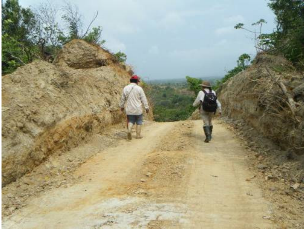
Foto 7 Camino que muestra que las capas de suelo han sido destruidas, dificultando el hallazgo de vestigios arqueológicos.
