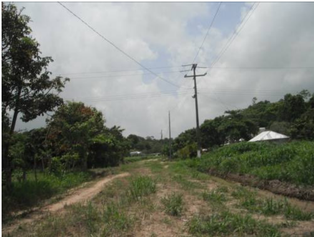
Foto 2 Vista de camino en Lázaro Cárdenas del Río
