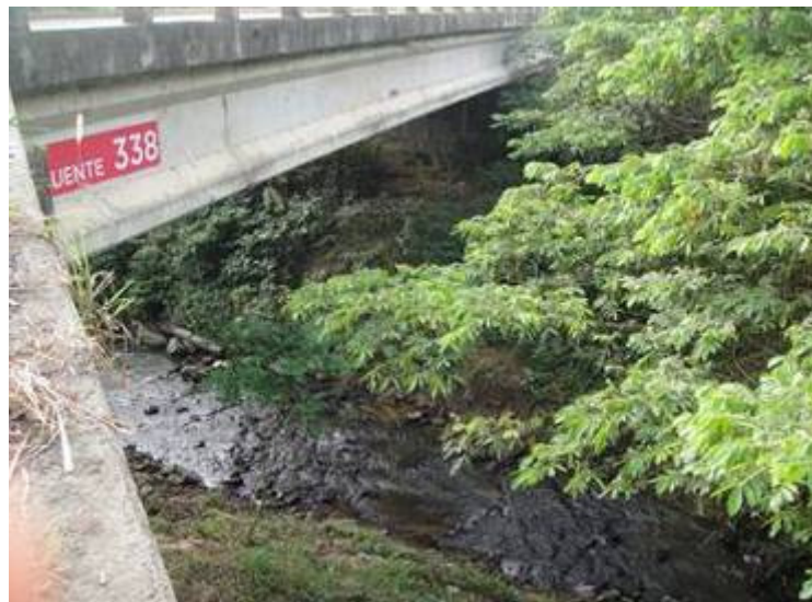
Vista del lecho bajo del puente vehicular
