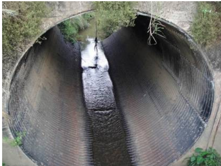
Alcantarilla para paso de agua del cauce norte, conformada por un tubo de 6 metros de diámetro en puente sobre la carretera del Complejo Resistol.
