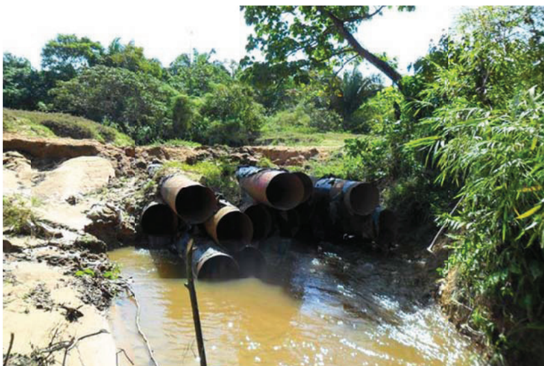
Foto 10. Tubos sobre el arroyo Gopalapa que sirven de puente sobre el derecho de vía de PEMEX.
