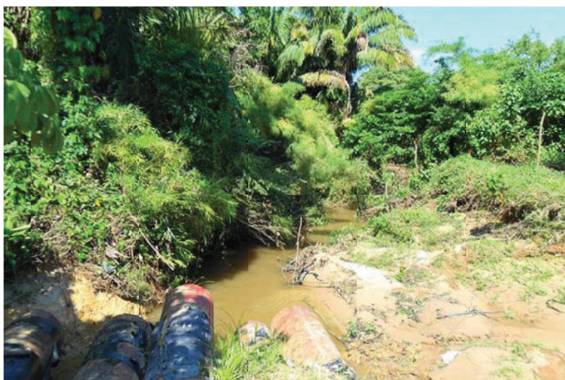
Foto 8. Arroyo Gopalapa , vista aguas abajo sobre el derecho de vía de PEMEX.
