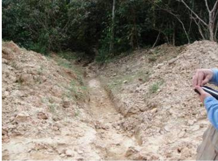
Escorrentamiento de agua que se encuentra sobre el camino central.
