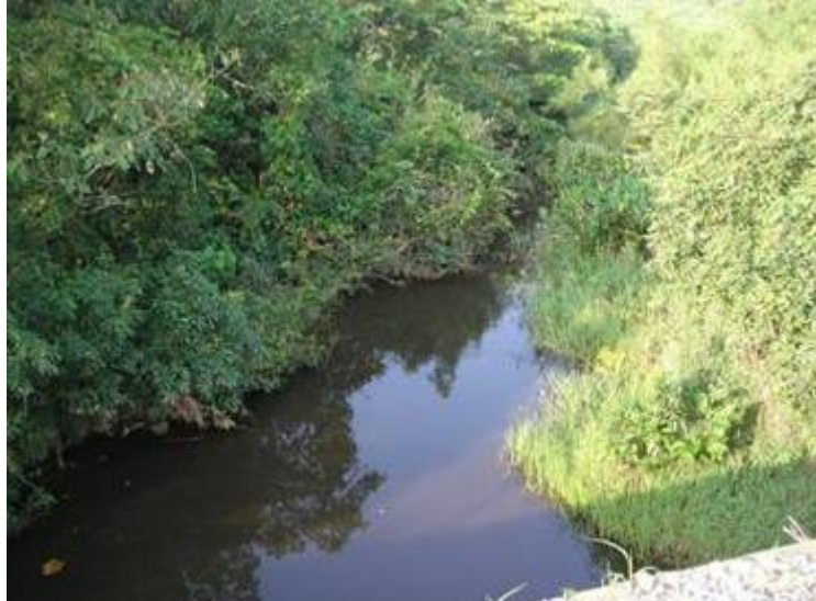
Vista del paso de agua sobre la vía aguas abajo.
