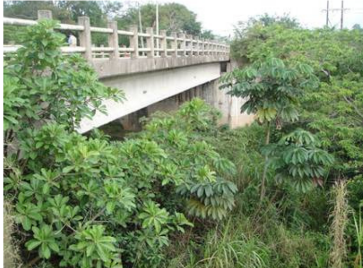
Vista lateral del puente vehicular que se encuentra sobre el cauce cercano a la comunidad "El pollo de Oro"
