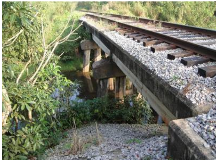
Paso de agua ubicado al sur del predio sobre la vía del ferrocarril
