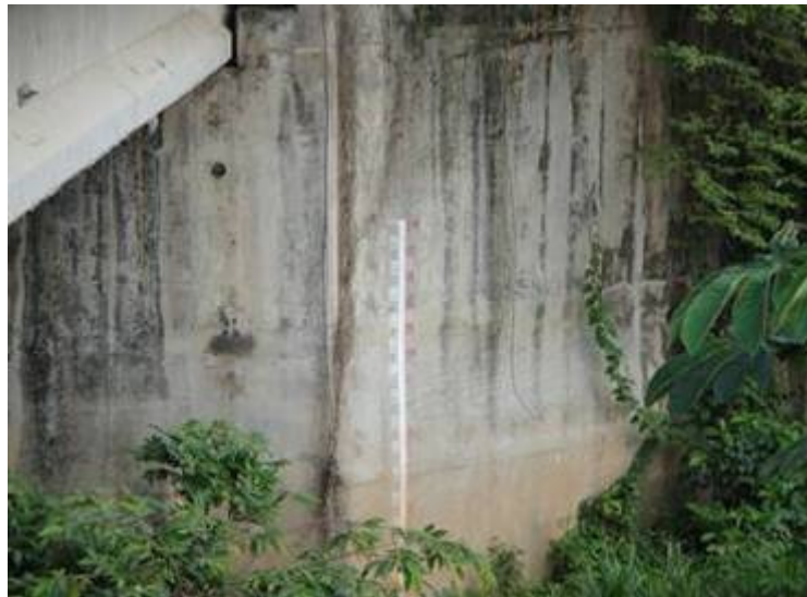
Vista de la regleta para nivel que está pintada en uno de los muros laterales del puente vehicular.
