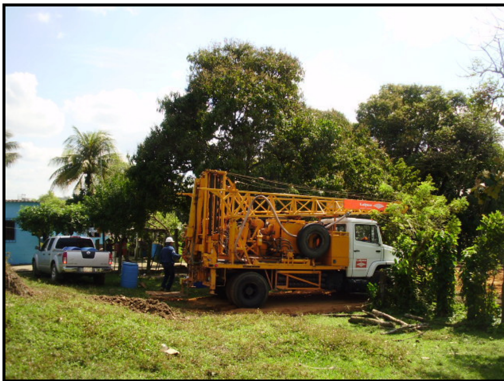
Foto 38. Perforación del pozo SB-13/MW-2y limpieza de materiales.
