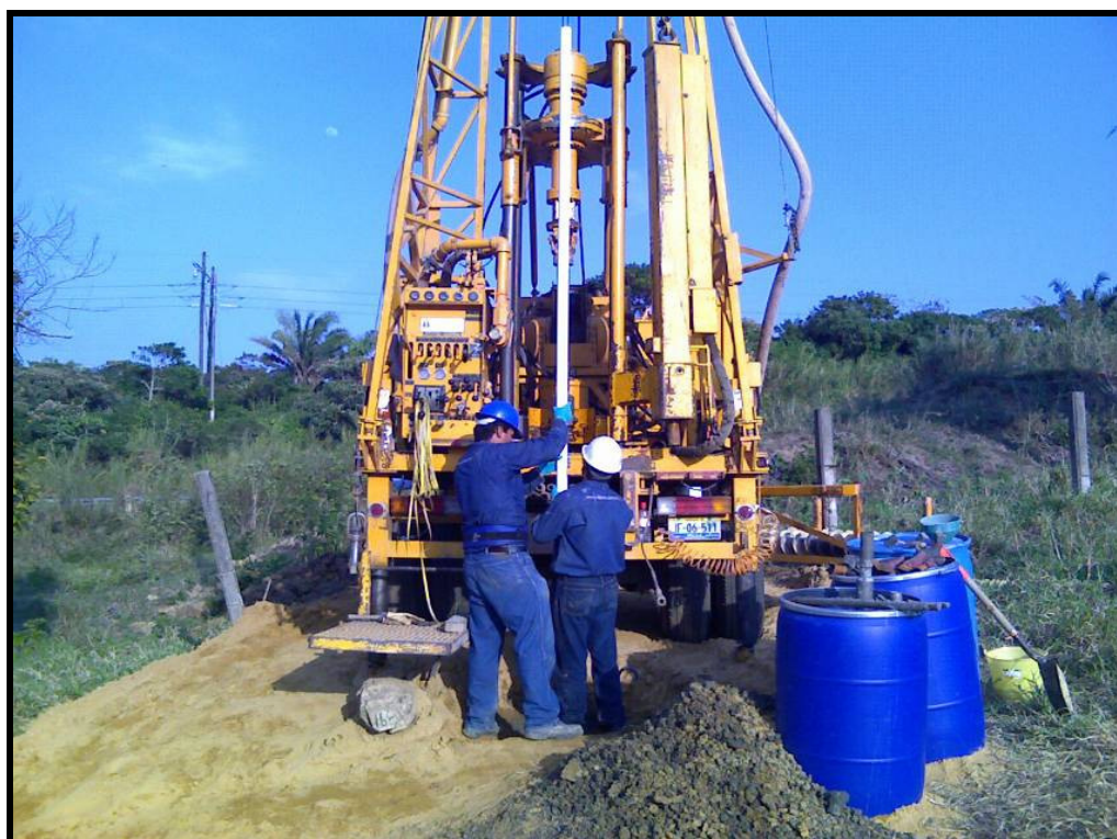
Foto 28. Instalación de la tubería en el Pozo SB-12/MW-1.
