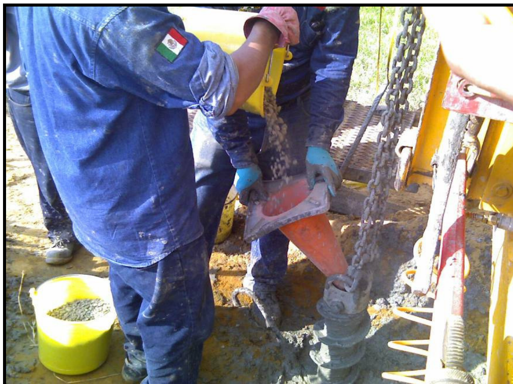
Foto 30. Instalación del sello de bentonita en el pozo SB-12/MW-1.
