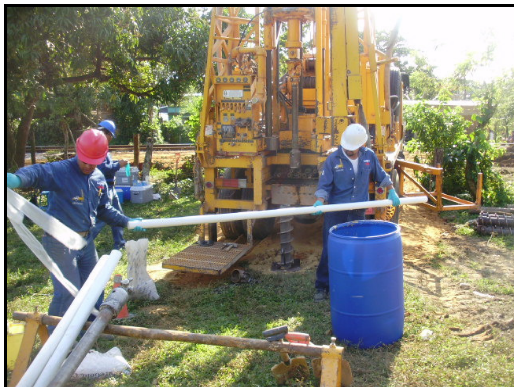
Foto 40. Instalación de la tubería de PVC en el Pozo SB-13/MW-2.
