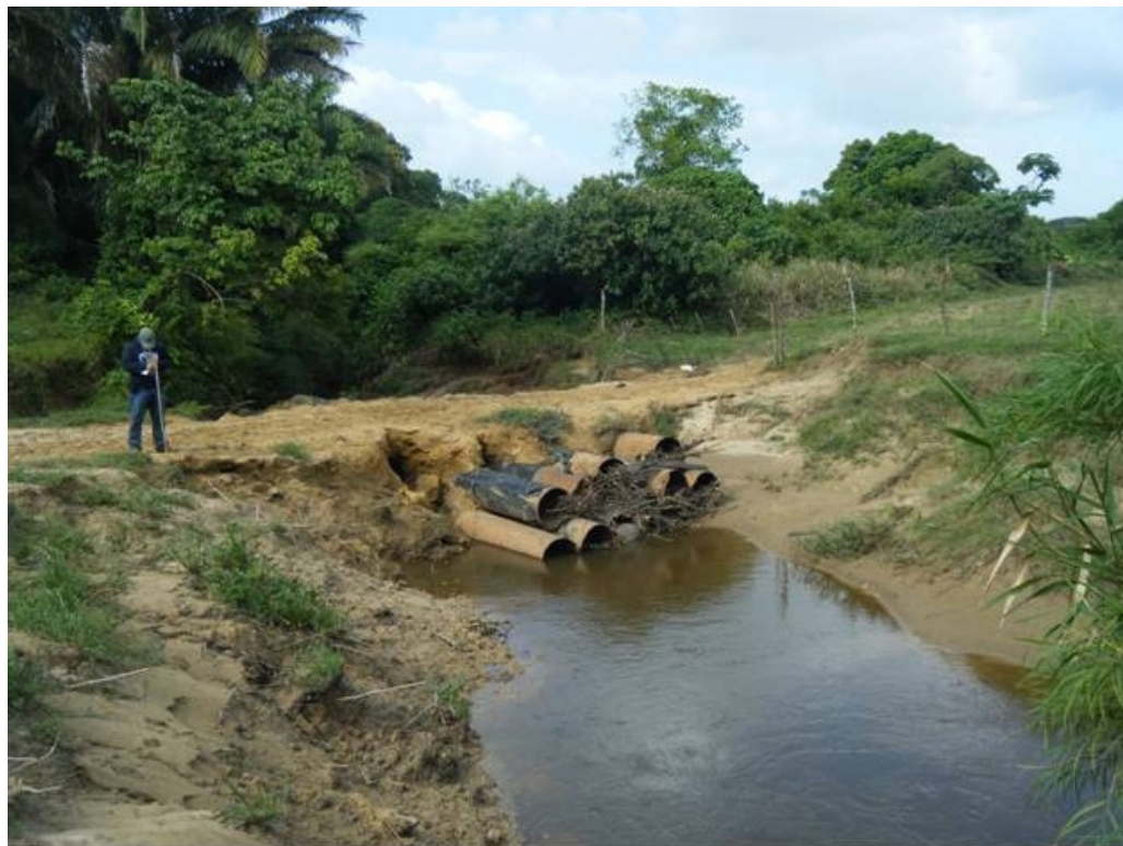
Foto 18 Vista del paso del arroyo Gopalapa, en el limite noreste del sitio. Se observa tubería de ductos utilizados como base para el paso de arroyo, cubiertos de tierra
