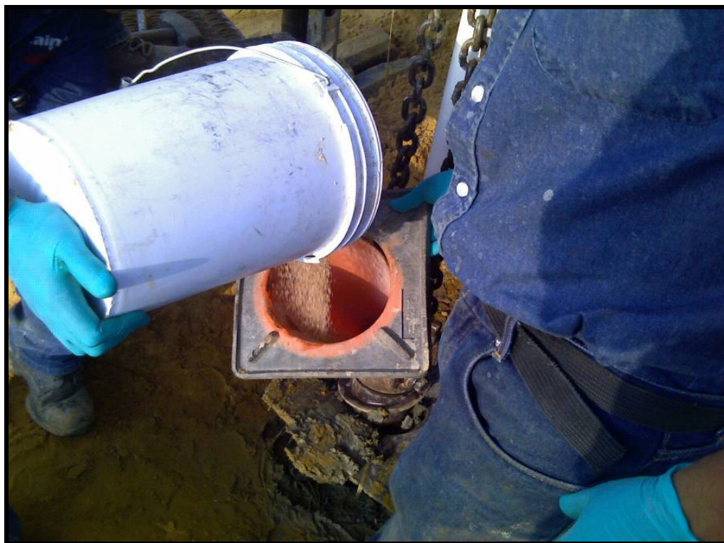
Foto 30. Instalación del sello de bentonita en el pozo SB-12/MW-1.
