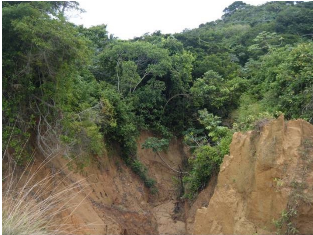
Foto 12 vista de la parte central del predio donde se observaron zona deslavadas
