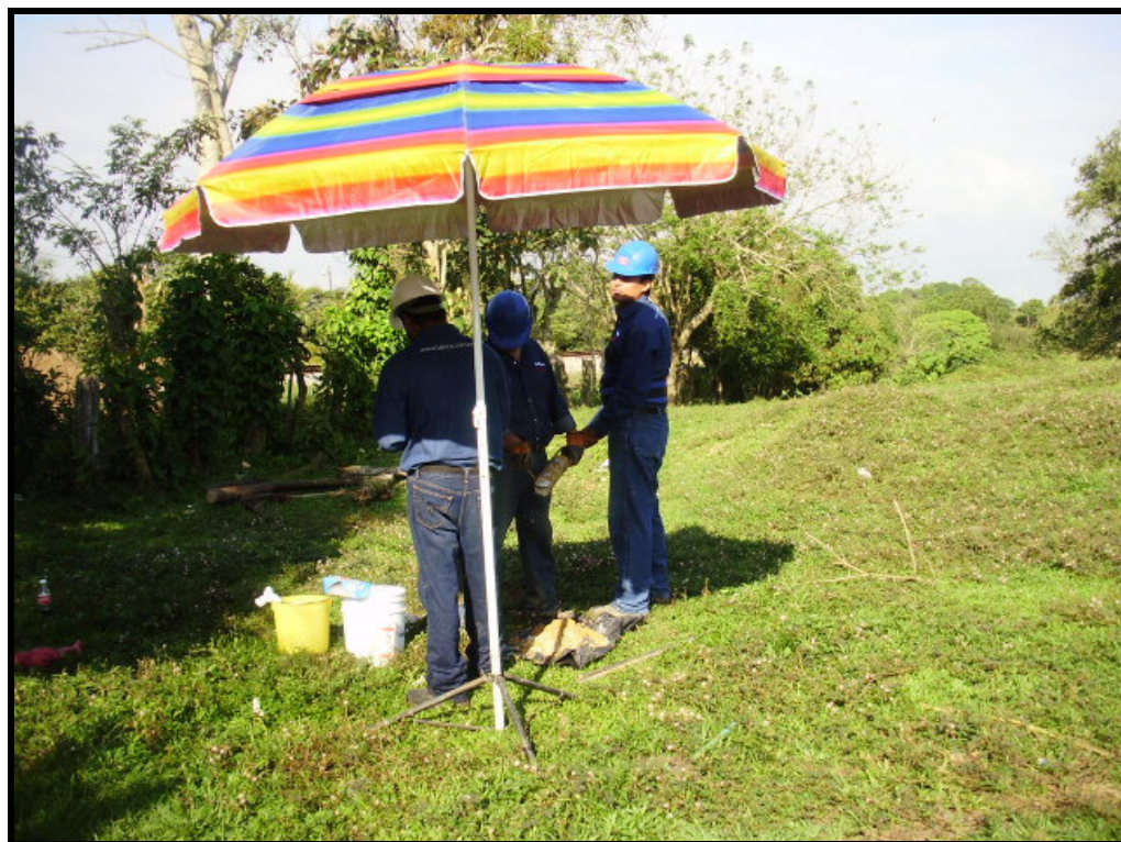
Foto 36. Puntos de verificación para descartar instalaciones subterráneas en el pozo SB-13/MW-2.
