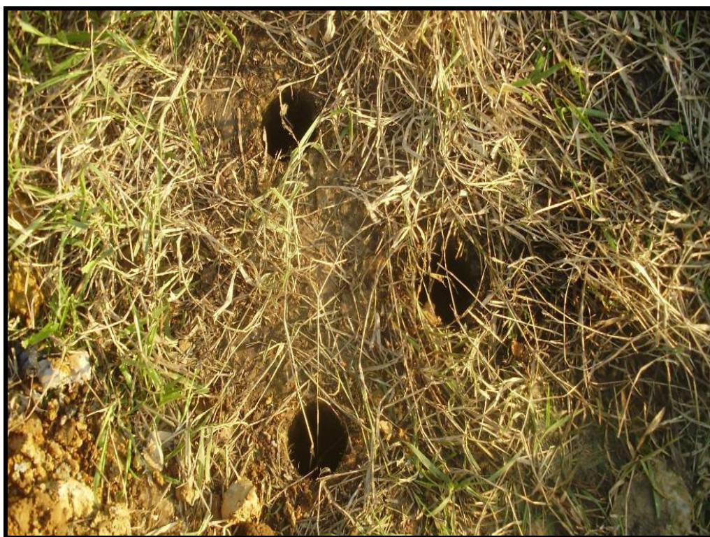
Foto 24. Puntos de verificación para descartar instalaciones subterráneas (SB-12).
