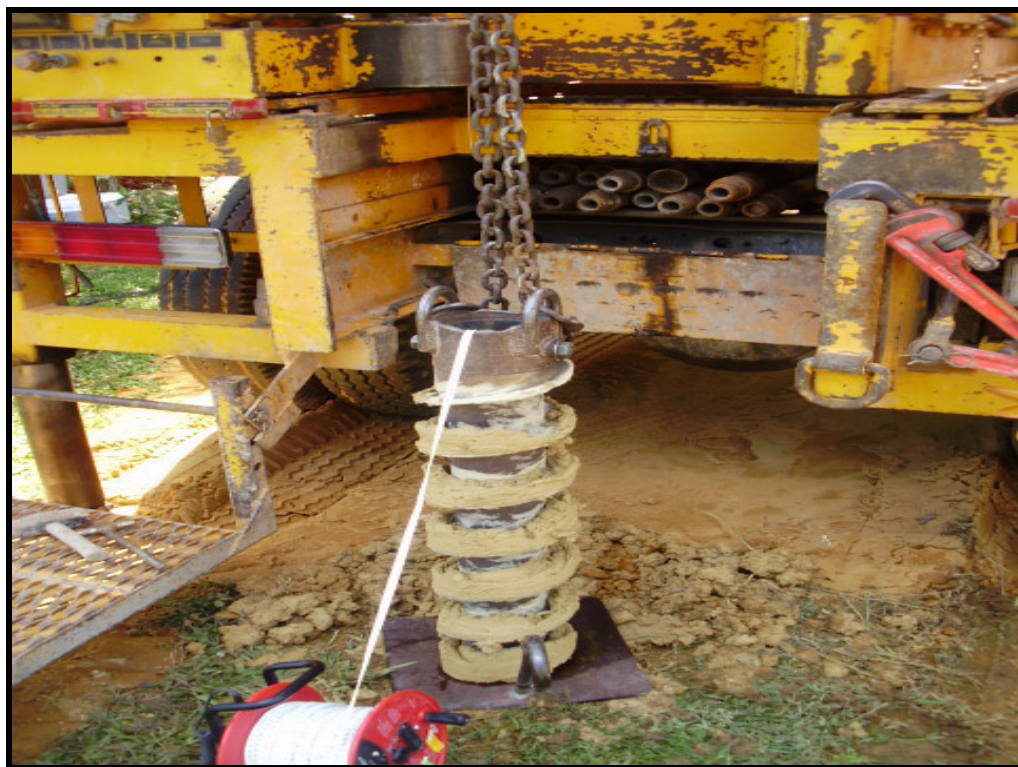
Foto 40. Instalación de la tubería de PVC en el Pozo SB-13/MW-2.
