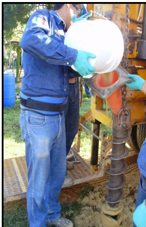
Foto 42. Instalación del sello de bentonita en el pozo SB-13/MW-2.
