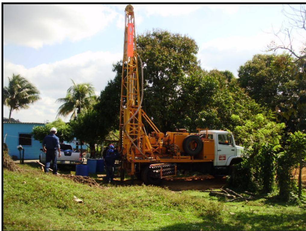
Foto 38. Perforación del pozo SB-13/MW-2y limpieza de materiales.
