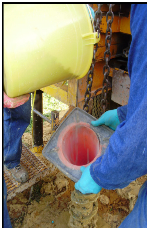
Foto 42. Instalación del sello de bentonita en el pozo SB-13/MW-2.
