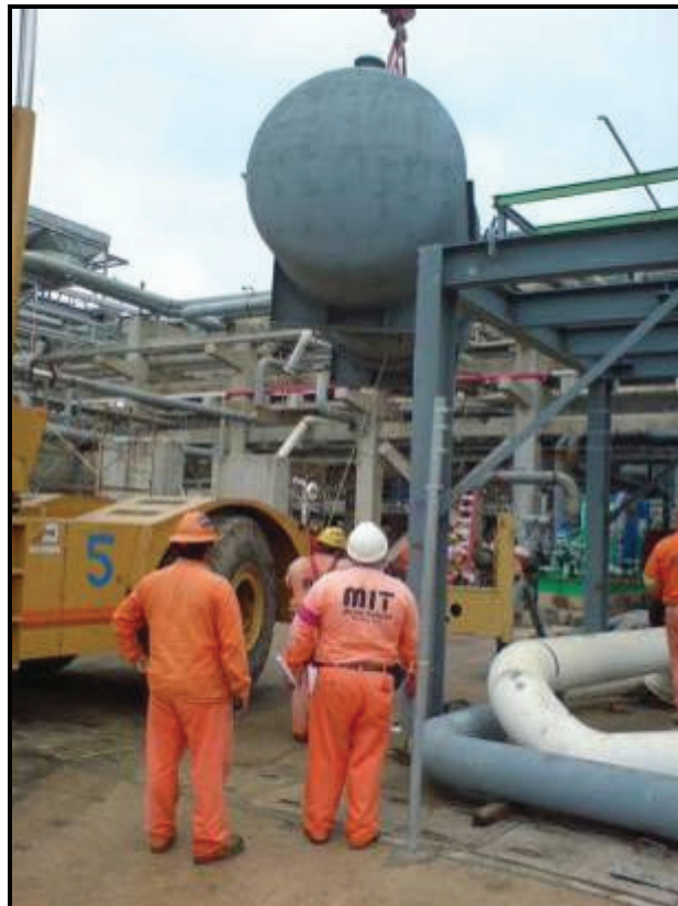
Figura 3. 31 Vista de la instalación de un equipo estático
