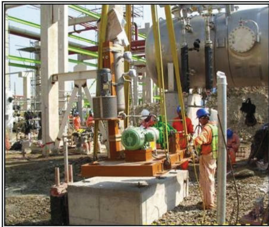
Figura 3. 32 Vista de la instalación de un equipo dinámico sobre una base
