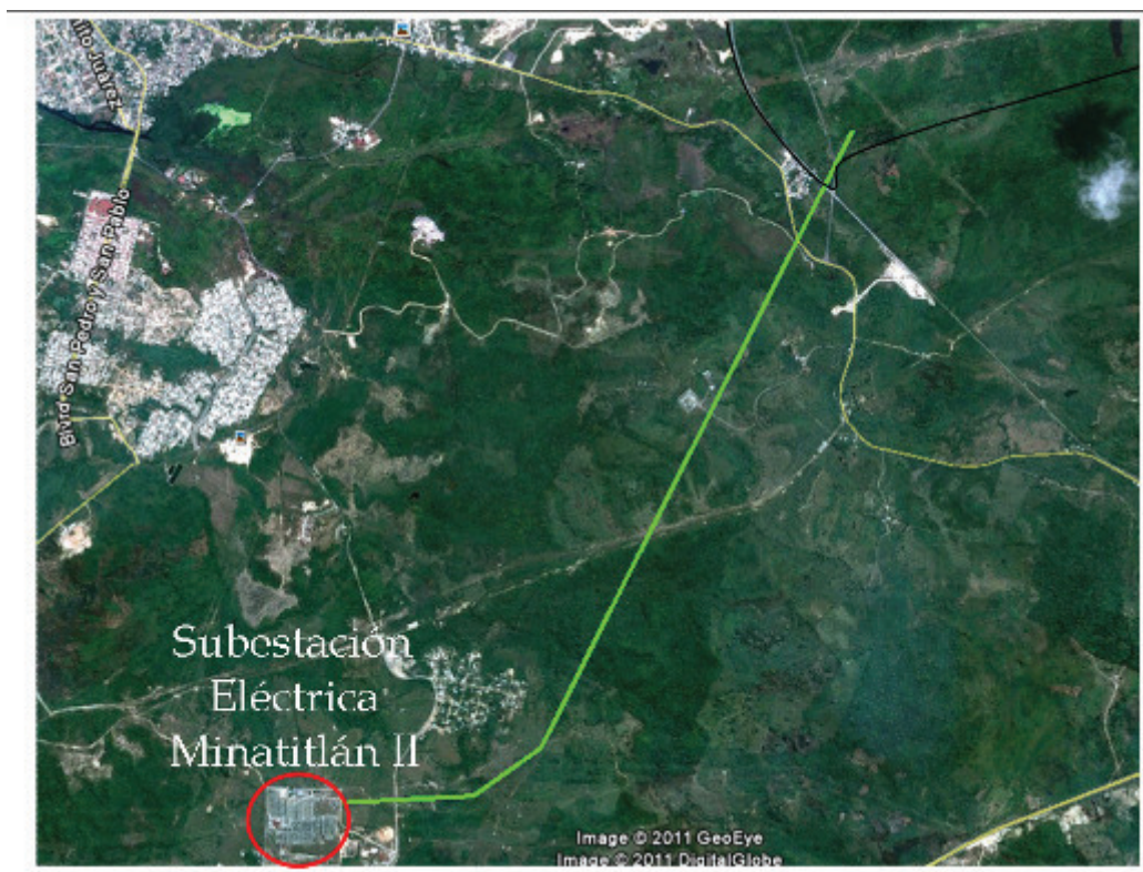
Figura 3. 47 Línea de transmisión eléctrica
