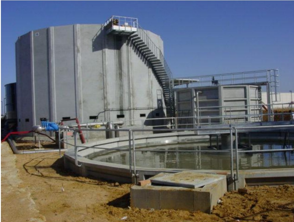
Ci-dessus : la bache d'homogénéisation et le réacteur bactériologique (prototype)
