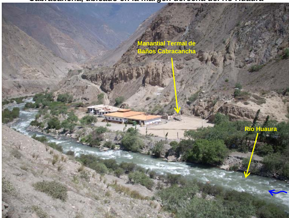
Foto 3-3 Vista de la infraestructura y captación de los Baños Termales Cabracancha, ubicado en la margen derecha del río Huaura
