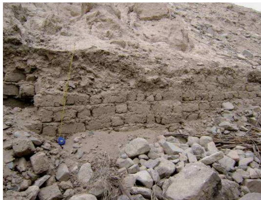
Foto 2.- Vista del muro de adobes.
