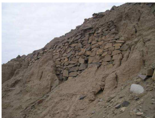
Foto 1.- Muros de tapial adosados a muros de piedra
