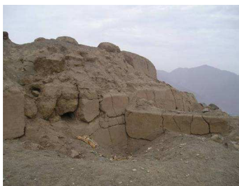
Foto 2.- Muros de tapial en la parte alta del sitio.
