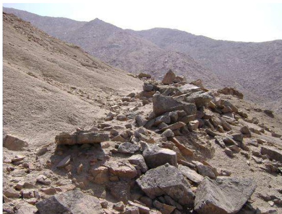
Foto 1.- Detalle del muro pircado.
