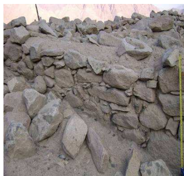
Foto 2.- Detalle de un muro.
