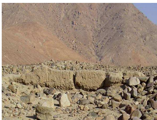
Foto 2.- Detalle de muro de tapia.
