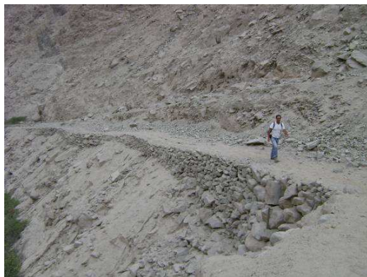
Foto 1.- Camino y muro de contención inferior.
