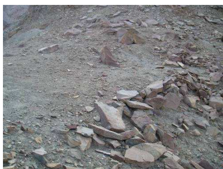
Foto 1.- Muro de una de las estructuras.
