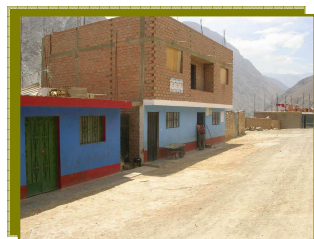
Viviendas de material noble del Centro Poblado de Huambo Alto
