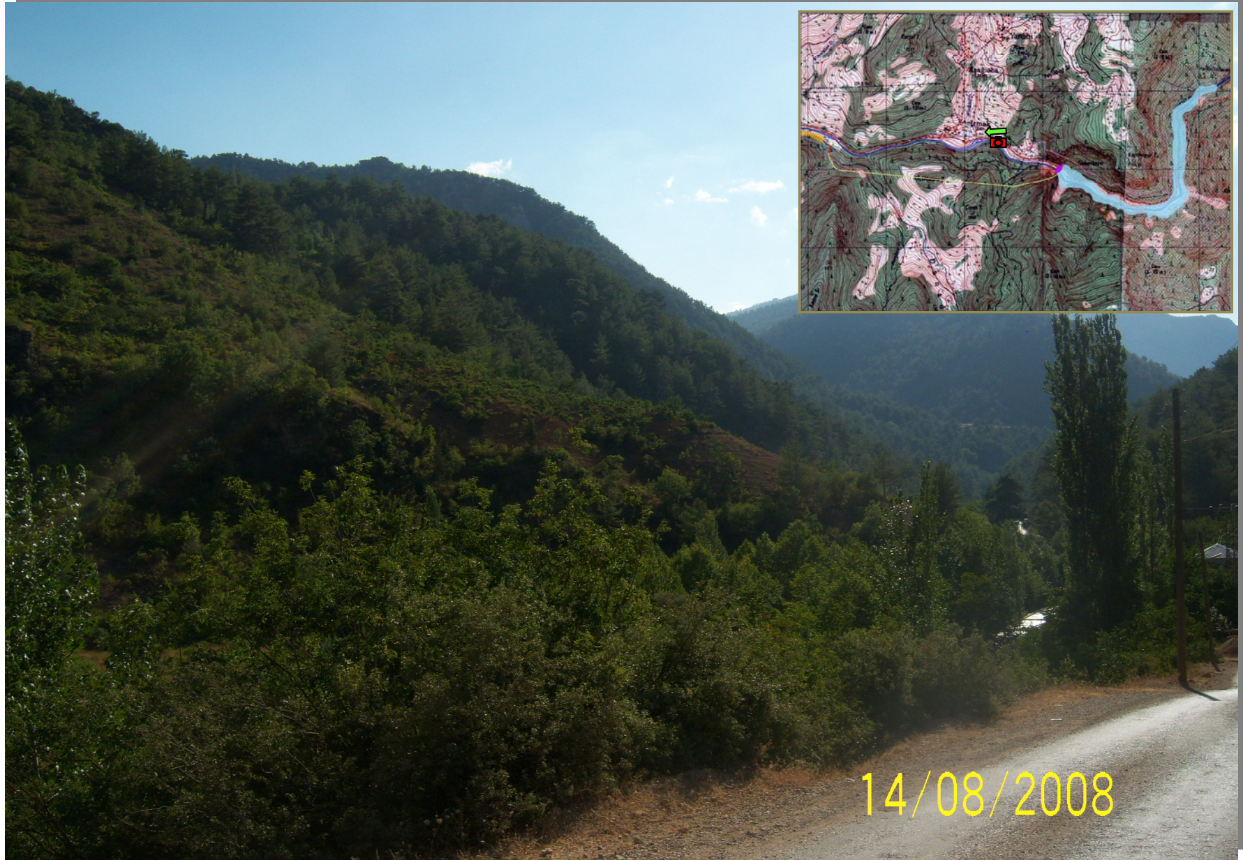
İLETİM TÜNELİ GÜZERGAHI,
