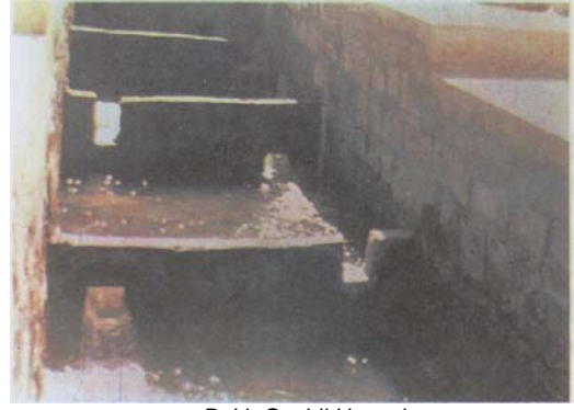
Balık Geçidi Havuzları
