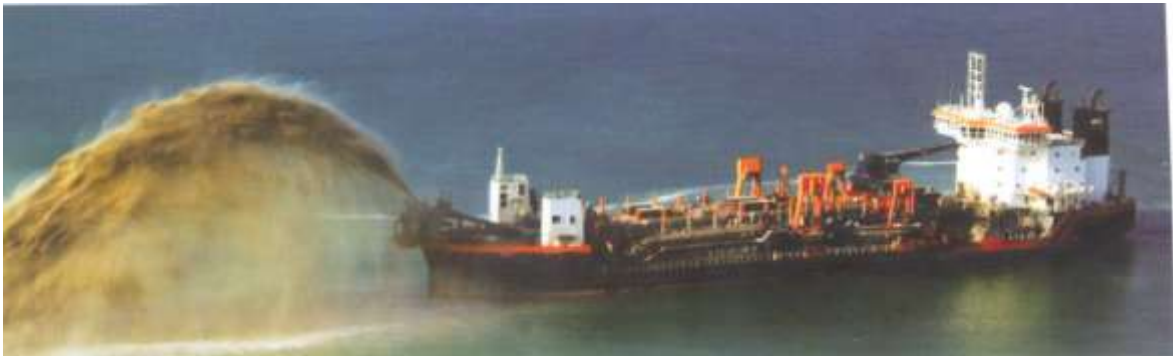
Figure 9 : Remblai de sables par refoulement à partir d'une drague suceuse
