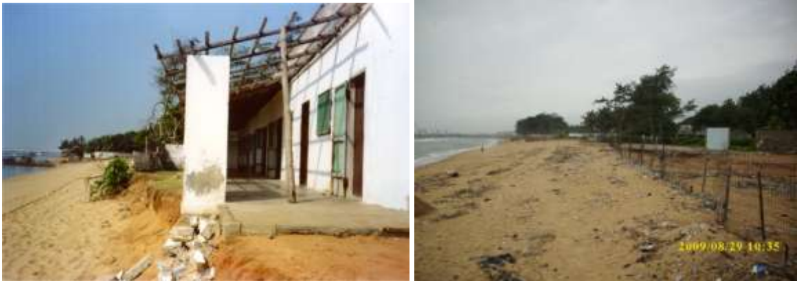
Figure 26 : Evolution de l'érosion à l'Est du port à l'hôtel Ramatou. Situation en 2007 (gauche) et en 2009 (droite)
