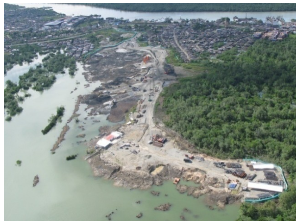
Fotografía 2. Zona intervenida Construcción TCBUEN S.A
