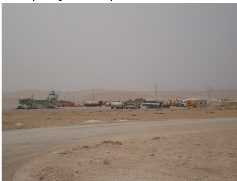
Photo : station de granulats à une distance de 5 km du site de la cimenterie
